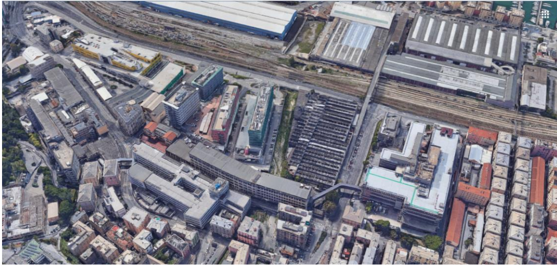
- VISTA AEREA DA MONTE -
