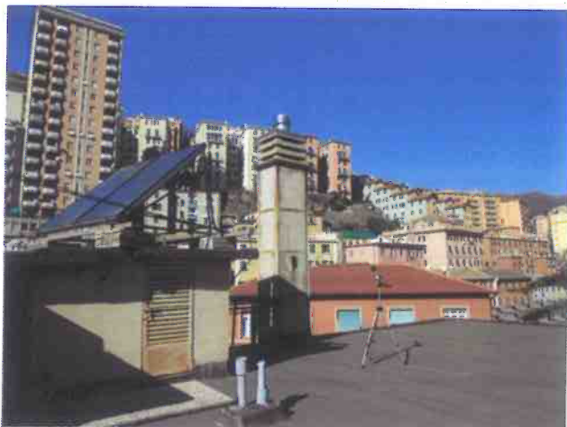
Foto 20 – S5 – Canna fumaria centrale termica.
