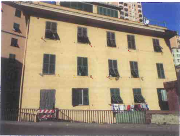
Foto 12 – Vista M5 – Via Montaldo.
