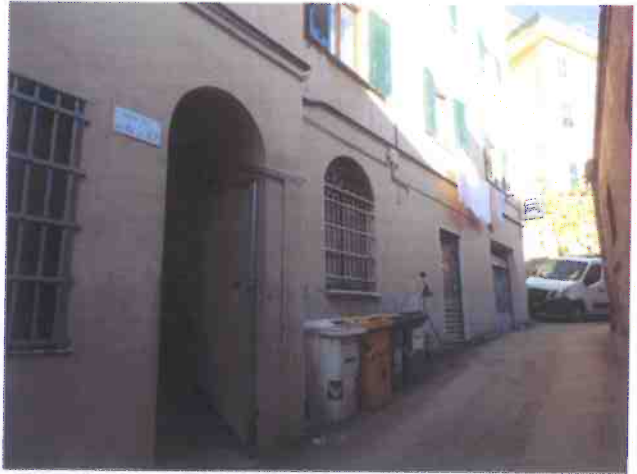
Foto 9 – Vista M2 – Via Vecchia civv. 6-10.
