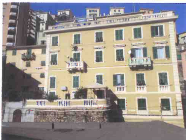
Foto 5 – Vista R2 – Via Vecchia civ. 20 - 22.
