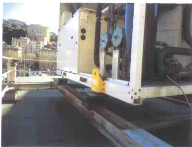
Foto 15 – Dispositivi antivibranti silent block.
