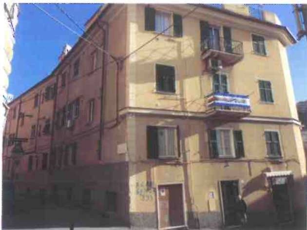
Foto 4 – Vista R1 – Via Vecchia civ. 1.
