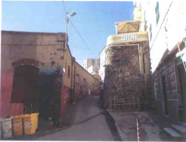
Foto 8 – Vista M1 – Via Vecchia civv. 20-22.
