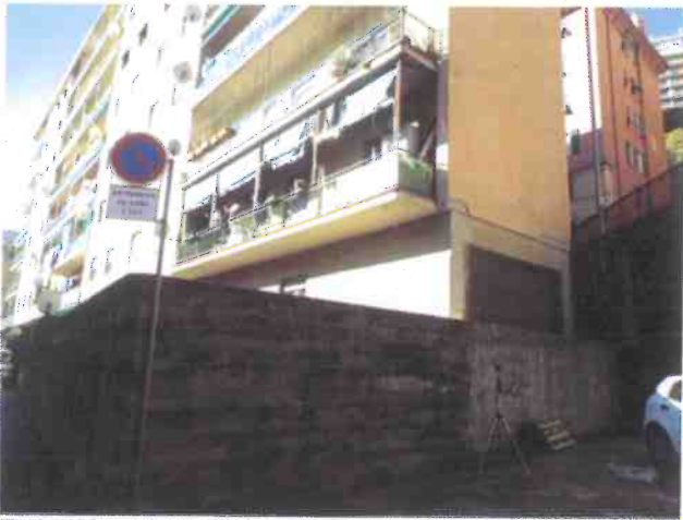
Foto 10 – Vista M3 – Via del Fossato civ. 6.
