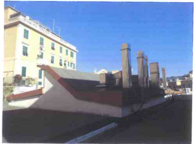
Foto 17 – Particolare torrini estrazione mensa.
