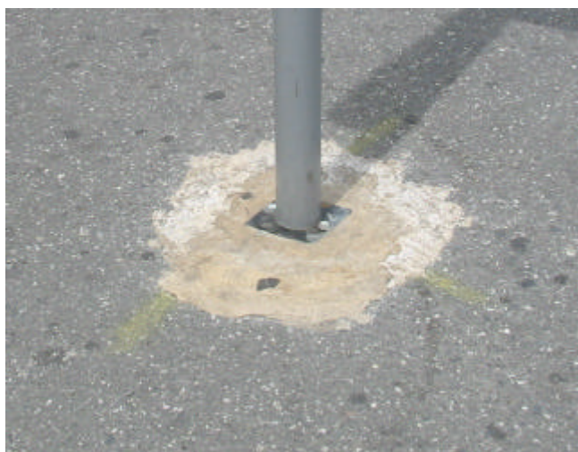
Riparto di cemento su asfalto da sostituire in questo caso con asfalto.
