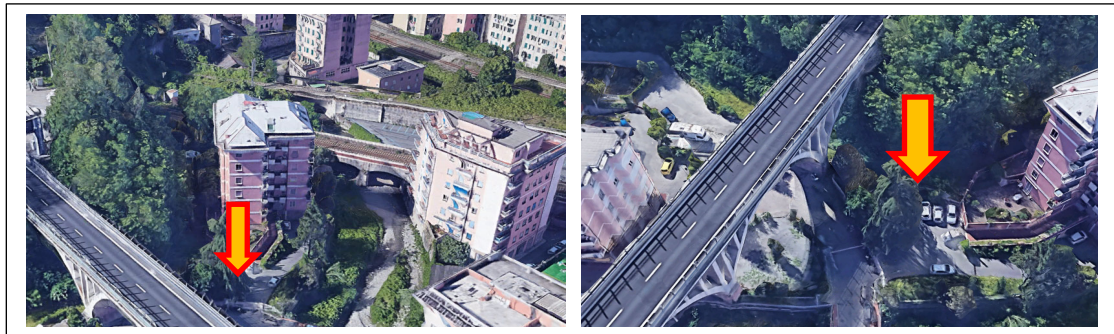
Figura 6-15: Vista a volo d'uccello dell'area interferita dall'opera (area pertinenziale al condominio)
