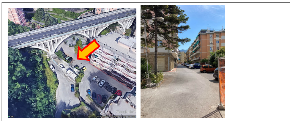
Figura 6-29: Foto aerea e altre viste della particella 937, Fg.34.
