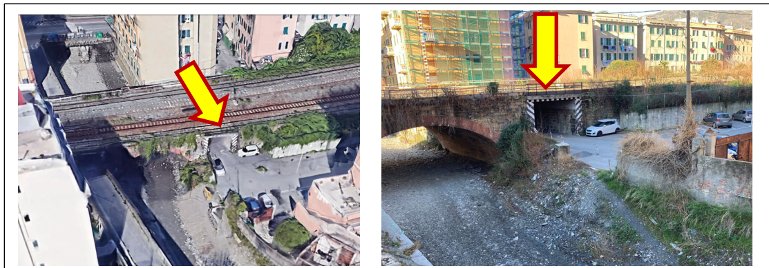
Figura 6-8: Foto della via in corrispondenza della particella 639, Fg.33
