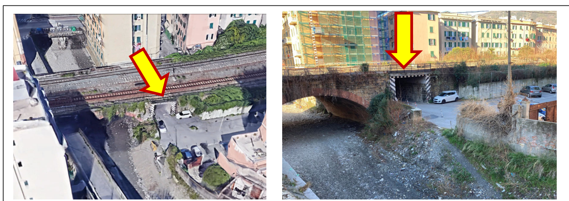
Figura 6-6: Foto aerea con evidenziata la part. 638, Fg.33 e vista del sottopasso
