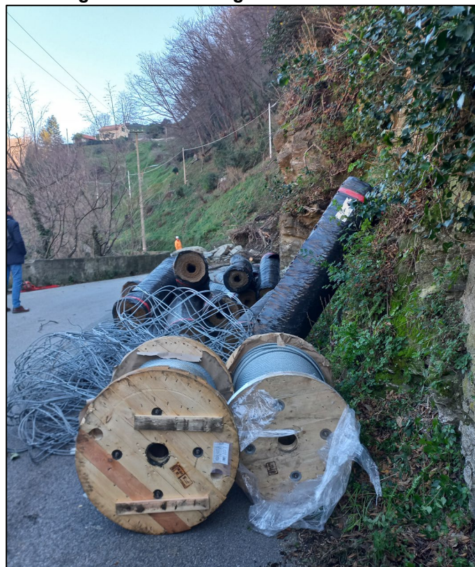
Figura 10: martedì 9 gennaio. Approntamento materiali per consolidamento parete
