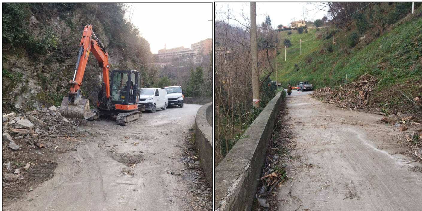
Figura 12: mercoledì 10 gennaio. Pezzatura piante e sgombero materiale in carreggiata
