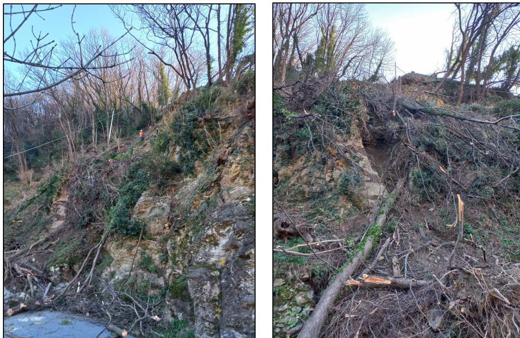
Figura 11: martedì 9 gennaio. Attività di disaggio e taglio piante in parete
