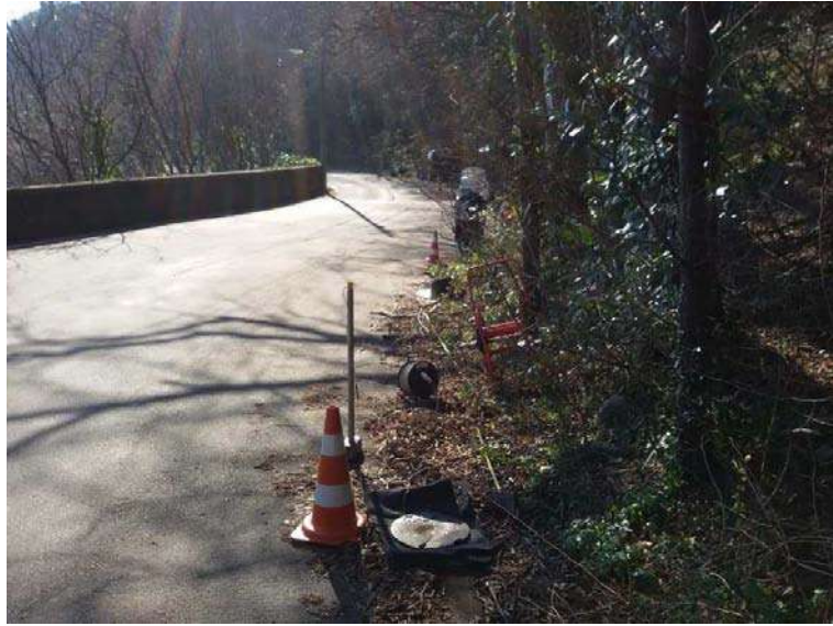
Stendimento sismico tomografico SS1, estremo finale (piastra in offset lato geofono G24)
