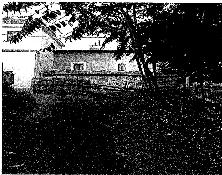
Fabbricato e strada di proprietà Sig. Usai
