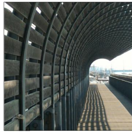
PONTE RIO SAN PIETRO
