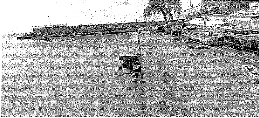
Foto 3 –la banchina con la pavimentazione in arenaria vista dal pontile superiore
