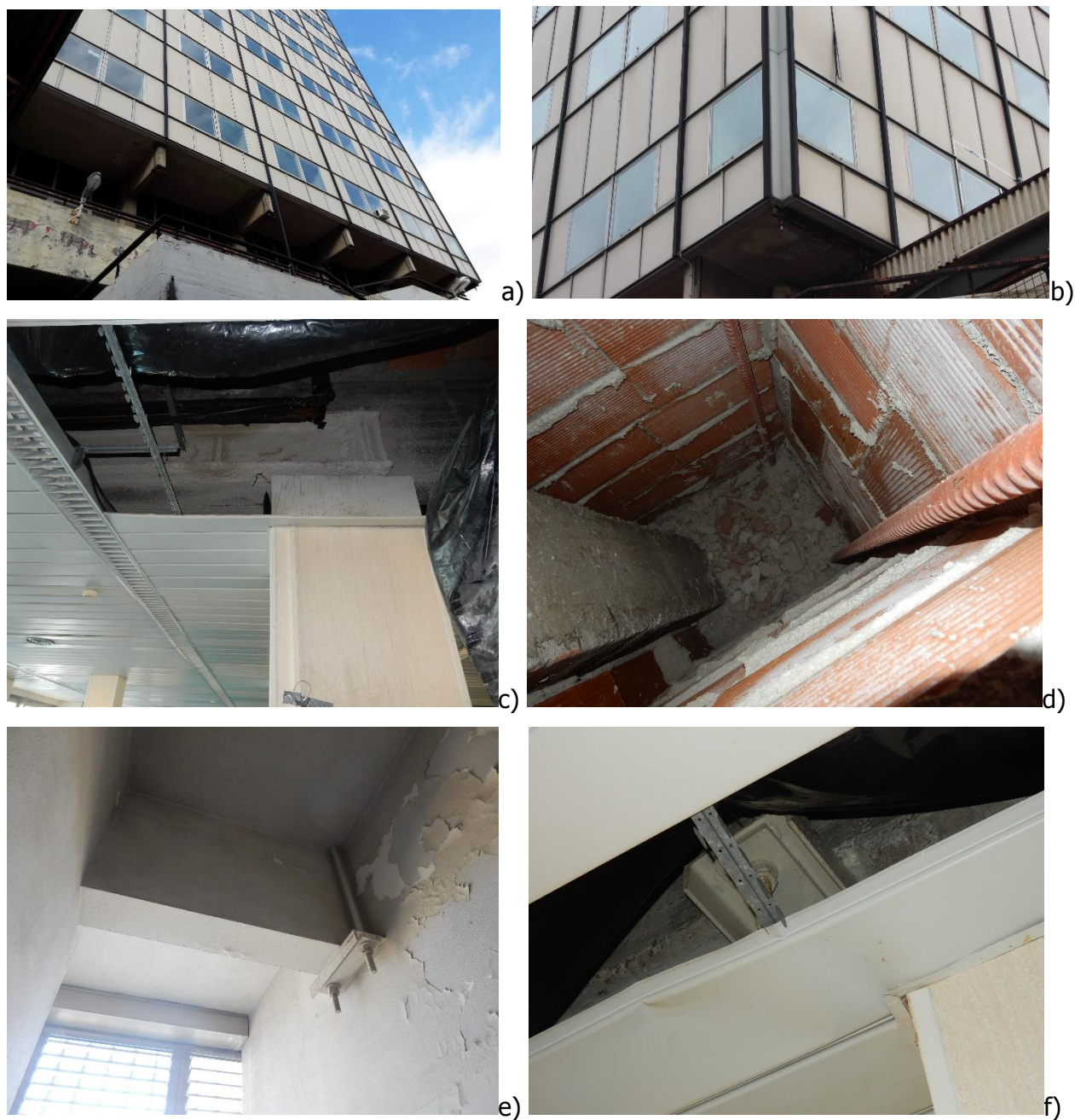
Figura 11. Sistema di rinforzo sugli elementi strutturali a sbalzo. a) Foto esterno dell'edificio - rinforzo delle travi a sbalzo; b) Foto esterno dell'edificio - rinforzo dei solai a sbalzo; c) Profilo a C affiancato alla trave del telaio principale in c.a. a sostegno dei cavi in acciaio - piano 8°; d) Doppie cavi di chiusura del sistema di rinforzo - piano 8°; e) e f) Ancoraggio dei doppi cavi di chiusura del sistema di rinforzo, all'intradosso della trave al piano 7°.
