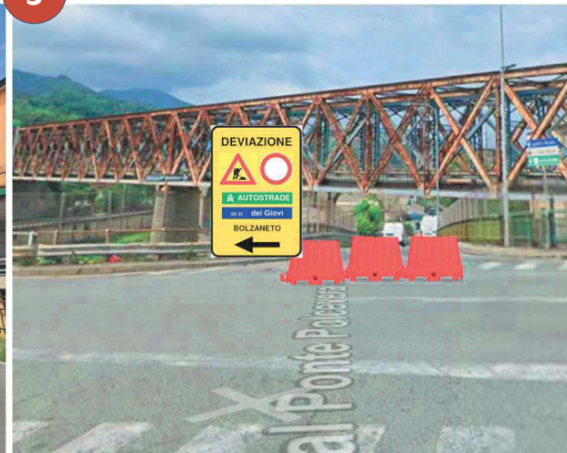
3 CHIUSURA VIA AL PONTE POLCEVERA DIR. MILANO
