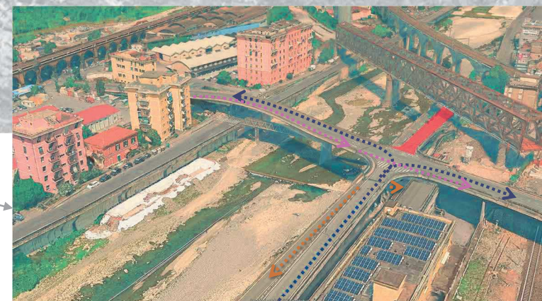
Via al Ponte Polcevera – Strada sopraelevata
