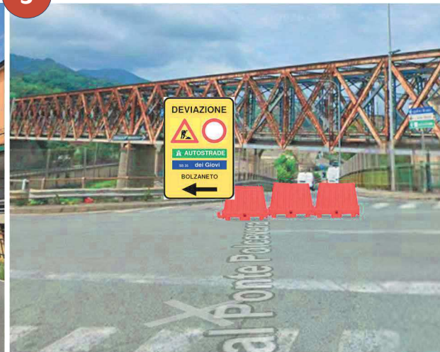
3 CHIUSURA VIA AL PONTE POLCEVERA DIR. MILANO
