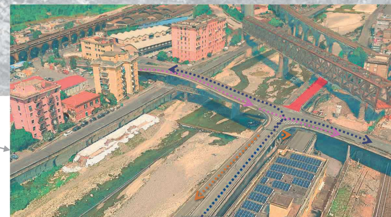
Via al Ponte Polcevera – Strada sopraelevata
