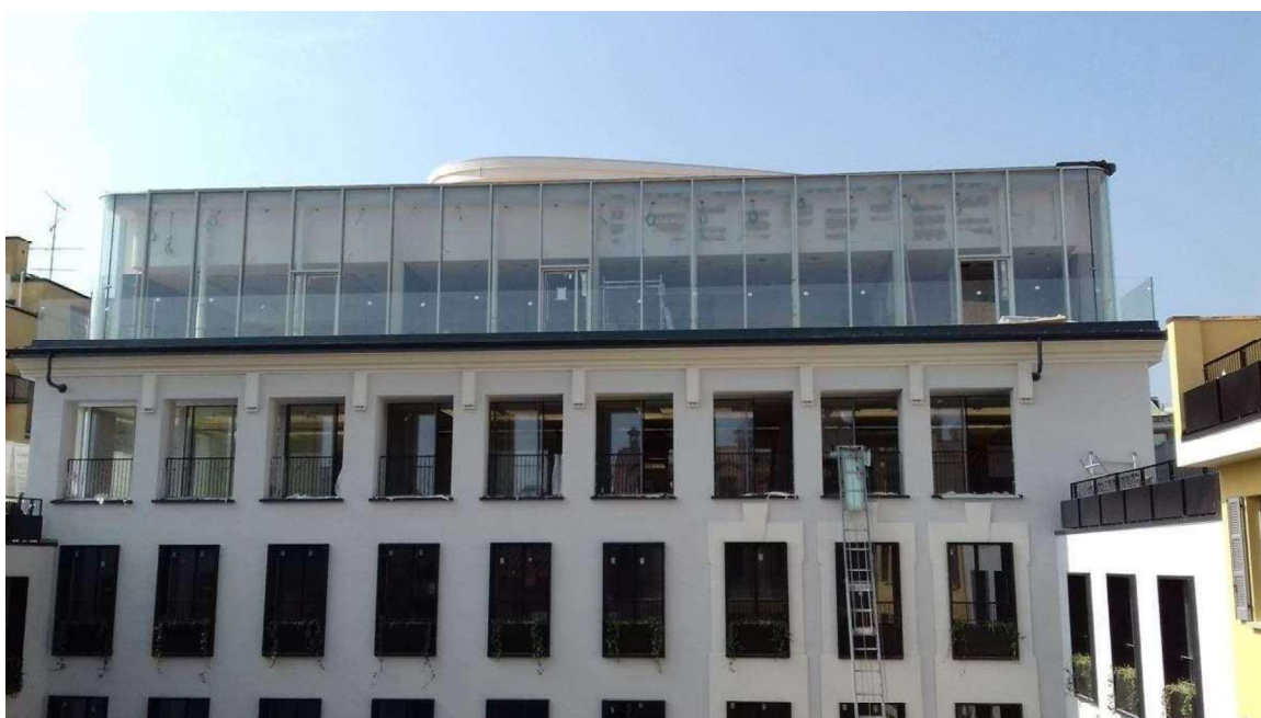
Unipol SAIS.p.a. – Antica Cà Litta – Milano: ristrutturazione del fabbricato sito in Milano, Corso di Porta Romana civ. 19 e Via Pantano civ. 26.
