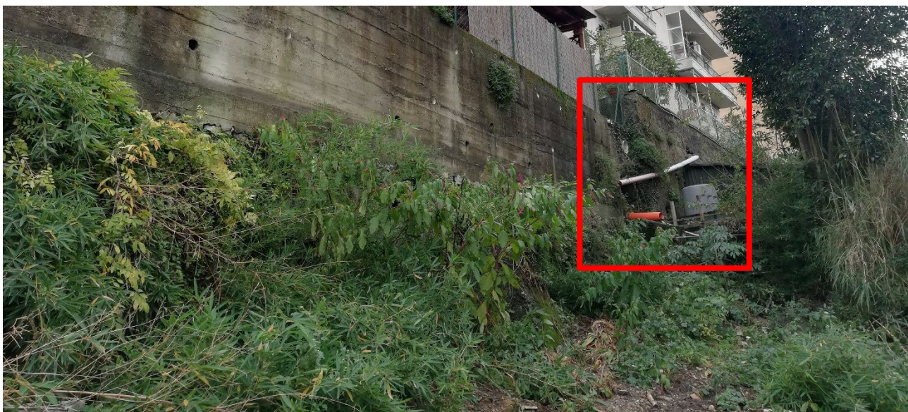
Figura 8: scarichi a cielo aperto
