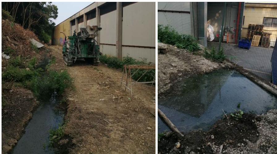
Foto 10 - Foto 11: a sx durante l'ultima campagna geognostica è stato "bonificato" il settore basale della scarpata per realizzare l'accesso alle attrezzature atte all'indagine, confinando i liquami ruscellanti in canale/solco provvisorio. A dx resta tuttavia lo scarico finale a cielo aperto presso gli adiacenti spazi commerciali dell'area ex Macelli
