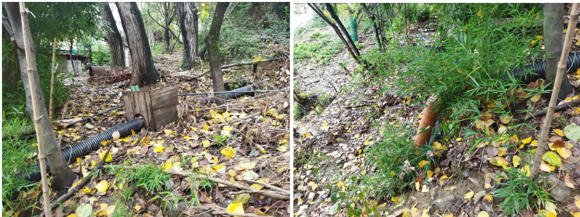
Foto 6 - Foto 7: Linee fognarie "improvvisate" lungo la scarpata
