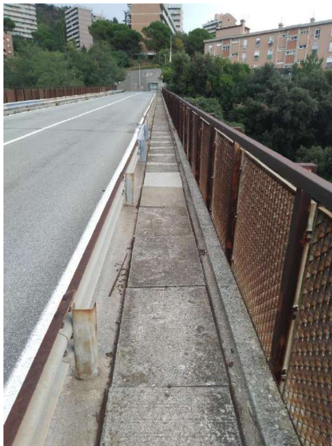
Vista sezione stradale e marciapiede
