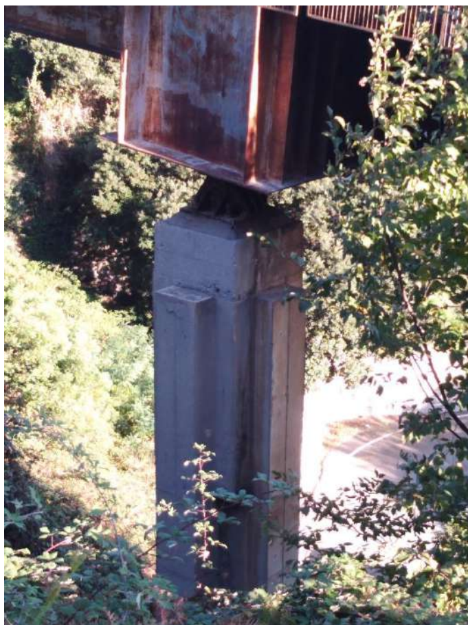
Dettaglio appoggio pile
