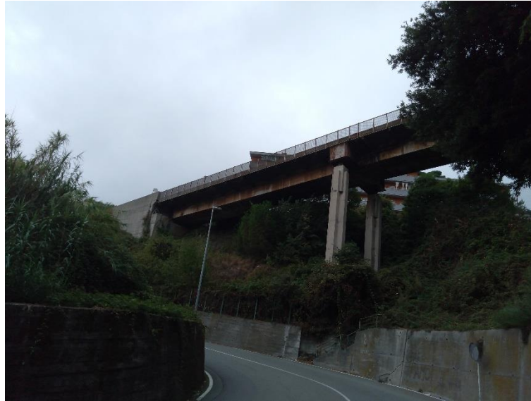
Vista inferiore impalcato
