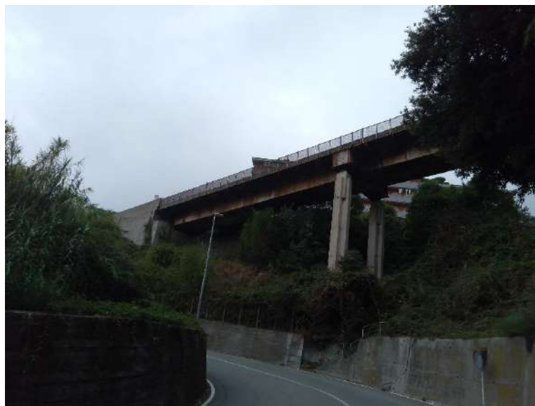
Vista inferiore impalcato
