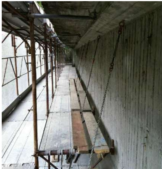
Tipo di ancoraggio e catene di sostegno
