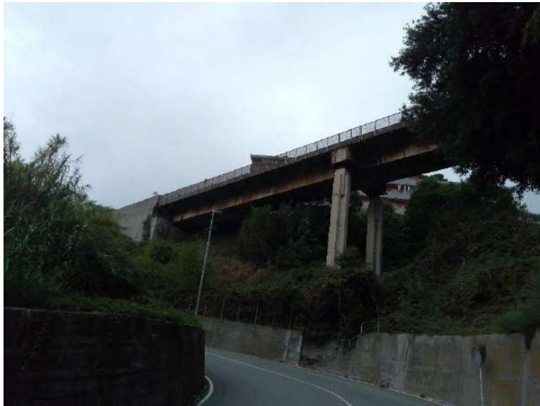
Vista inferiore impalcato
