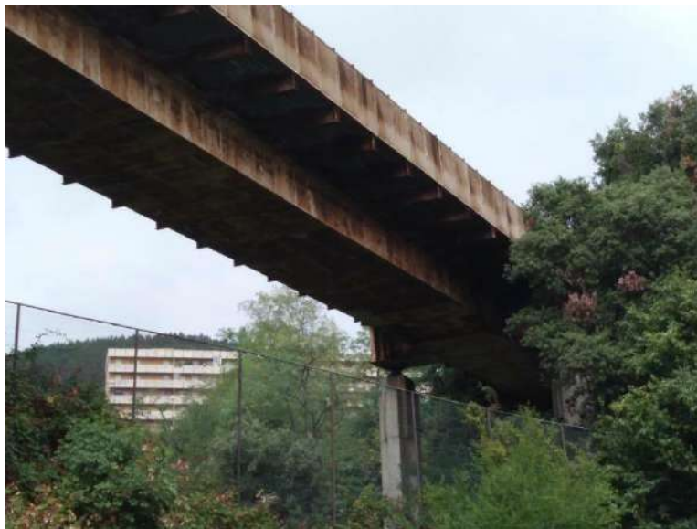
Vista inferiore impalcato
