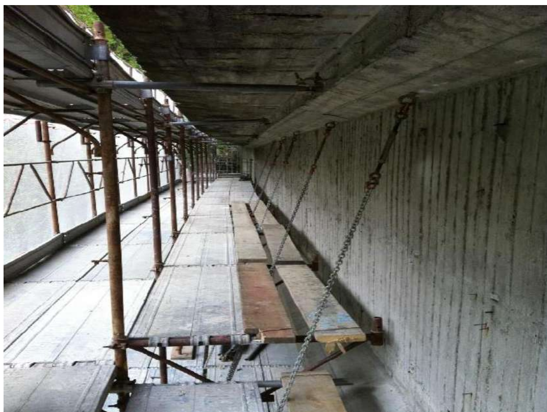
Tipologico ancoraggio e catene di sostegno
