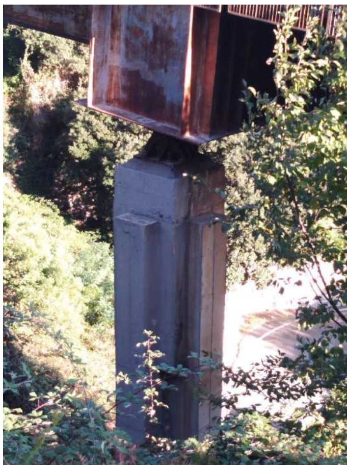
Dettaglio appoggio pile
