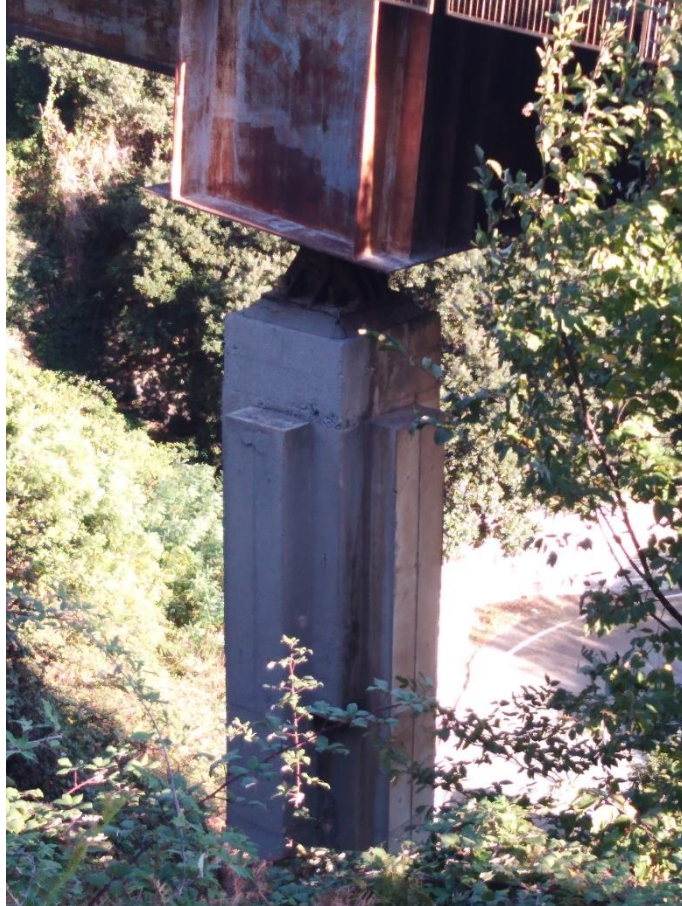
Dettaglio appoggio pile
