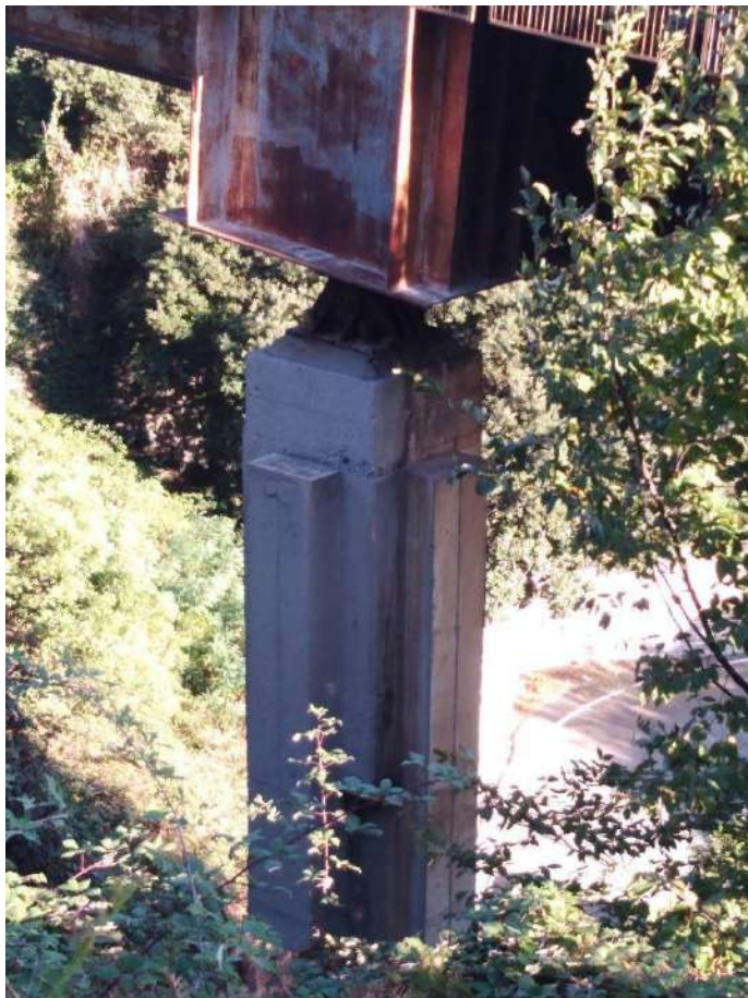
Dettaglio appoggio pile
