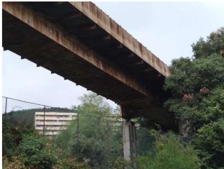
Vista inferiore impalcato
