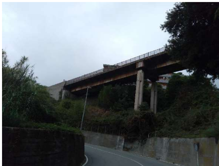
Vista inferiore impalcato
