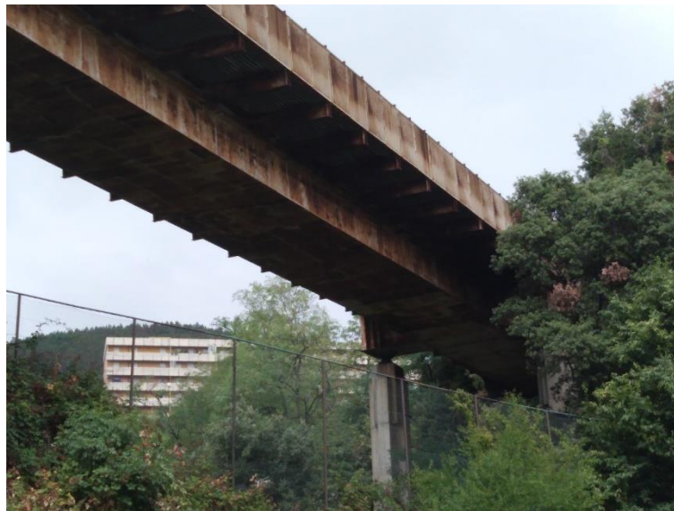
Vista inferiore impalcato
