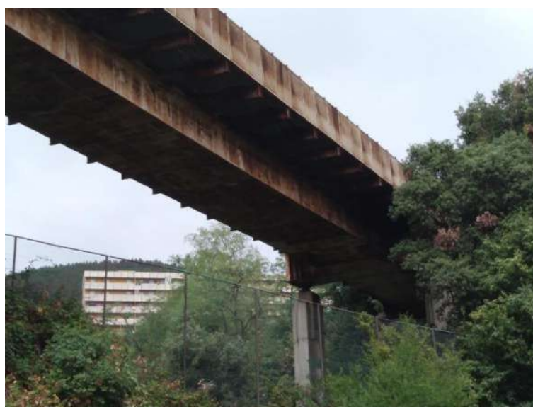
Vista inferiore impalcato
