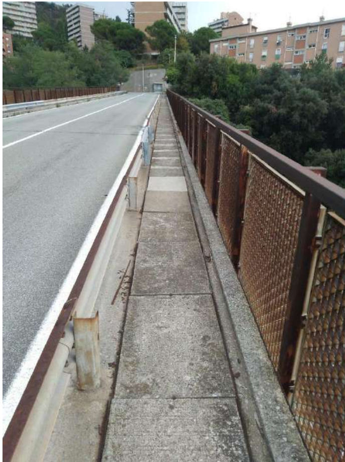
Vista sezione stradale e marciapiede
