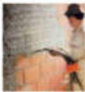
Realizzazione di intonaci esterni su superfici verticali e/o orizzontali mediante macchina intonatrice. L'applicazione dell'intonaco esterno richiede le seguenti accortezze ai fini di buoni risultati:
