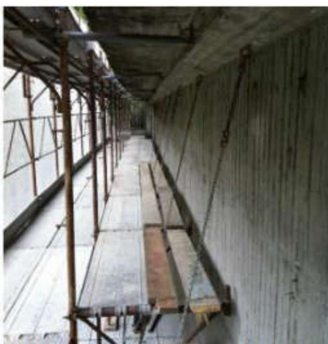
**Tipo di ancoraggio e catene di sostegno**
