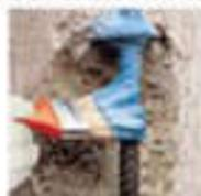
Trattamento di protezione anticorrosiva dei ferri di armatura che, per varie cause, si presentano scoperti, e per i quali il processo di corrosione, subisce una notevole accelerazione.
