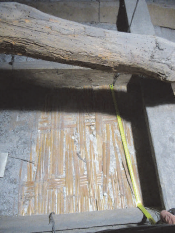
Img 2 - IMG0051: estradosso, pulitura canniccio; Img 3 - IMG0035: estradosso, detriti imposta di volta
