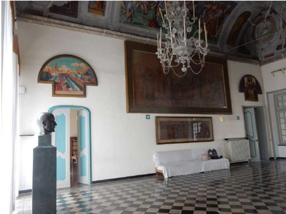
Foto: il salone su cui insiste la volta oggetto di intervento. L'immagine è antecedente all'inserimento della ponteggiatura, che ha previsto la rimozione del lampadario
