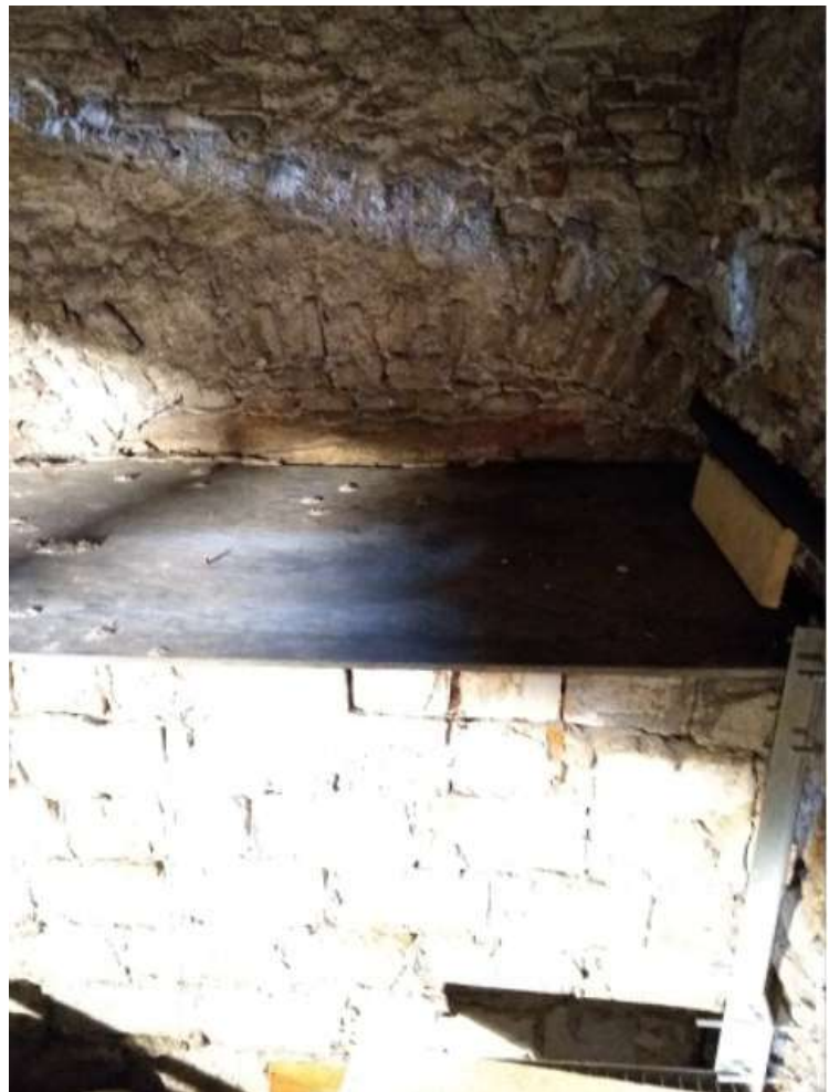
Foto: La nicchia che grava sulla volta
