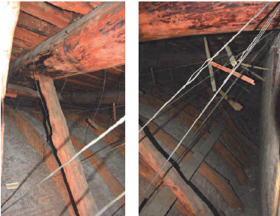
Immg. 4-5 – DSC_0063 e DSC_0062: estradosso della volta. È visibile la stuoia di canne intrecciate fissata alle centine. Non sono presenti pendini lignei ma solo in filo metallico, forse opera di un intervento successivo.
