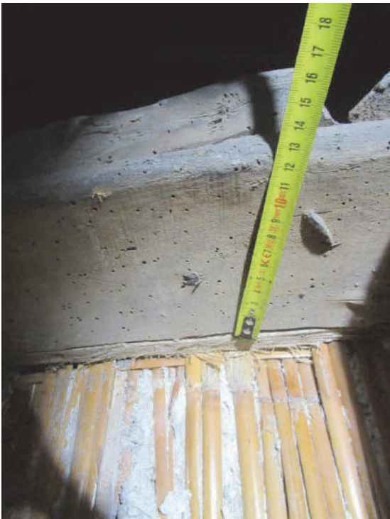
Img 5 – DSC0054: estradosso, fori di sfarfallamento insetti xilofagi; Img 6 - DSC0033: estradosso, rosura legno
