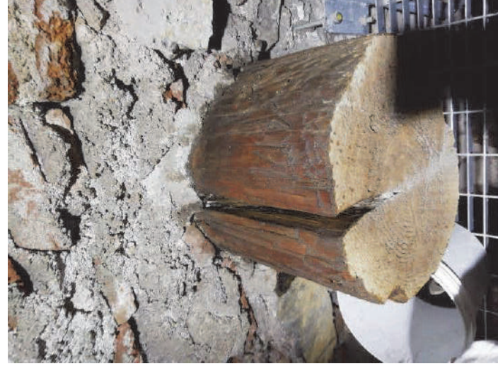
Part. Dopo l'intervento
