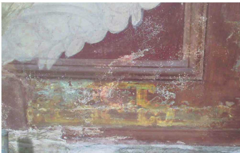
Img. 20 – IMG_0010: angolo nord-ovest, tracce di decorazione gialla e verde
