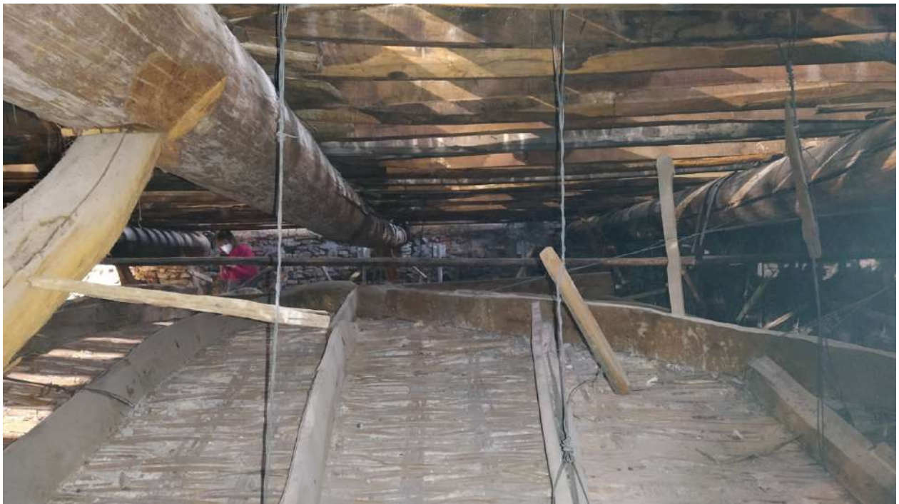
Foto: L'estradosso della volta fotografato dalla passerella. Si vedono il canniccio, le centine, i pendini , una trave e i travetti
