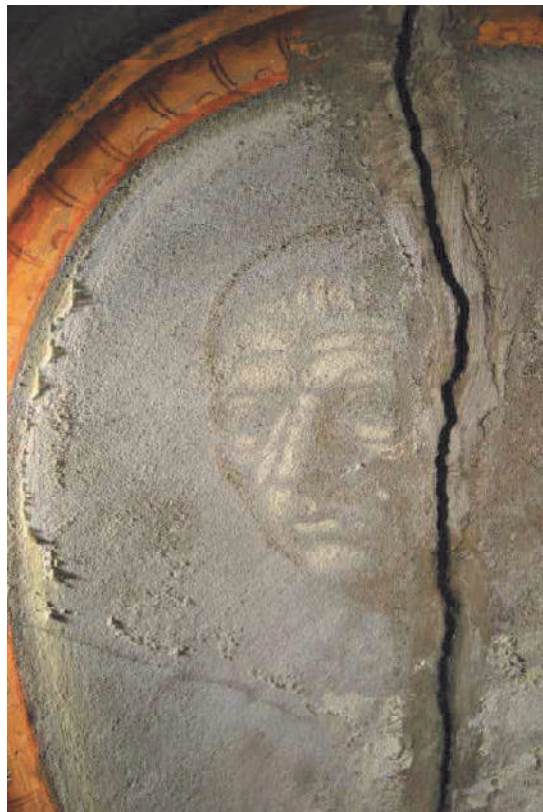
Img. 15– DSC_0624: efflorescenze molto estese sugli ovali dei medaglioni d'angolo che sono stati oggetto di ridipintura.
