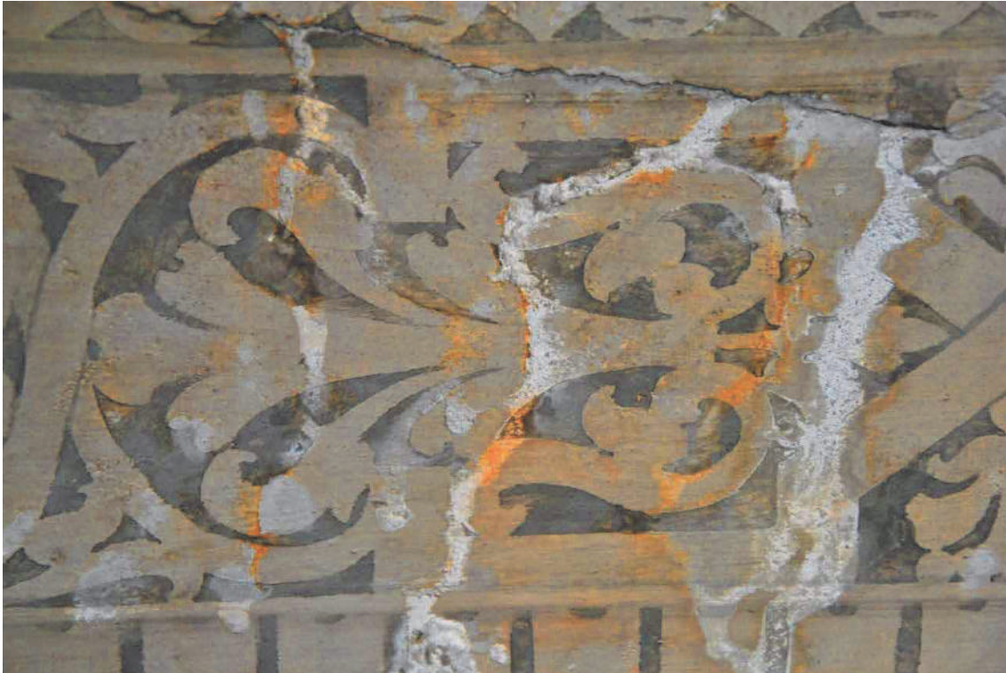
Img. 20 – DSC_0717: cornice superiore alla specchiatura nord, fessurazione, efflorescenze saline, colature e macchie da colatura di tannino.
