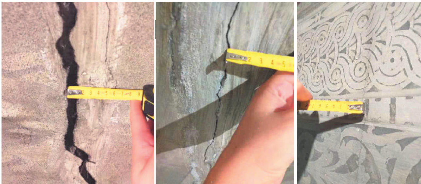
Imgg. 1, 2, 3 – foto_01, foto_02, foto_03: da sinistra a destra fotografie dell'ampiezza decrescente delle fessurazioni: ampia, media, sottile.
