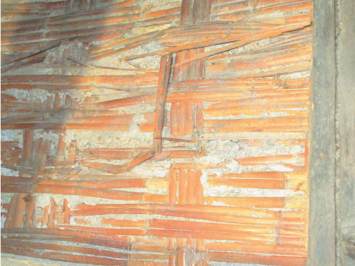
Img. 6 – IMG_0056: estradosso, stuoia di cannicchio a seguito di parziale pulitura del deposito incoerente.
