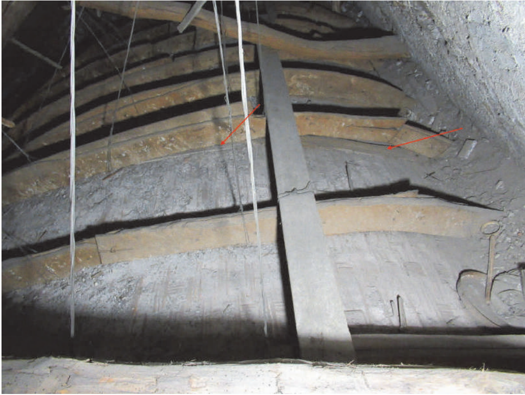
Img 4 – DSC0125: estradosso, anomalia centina sollevata
