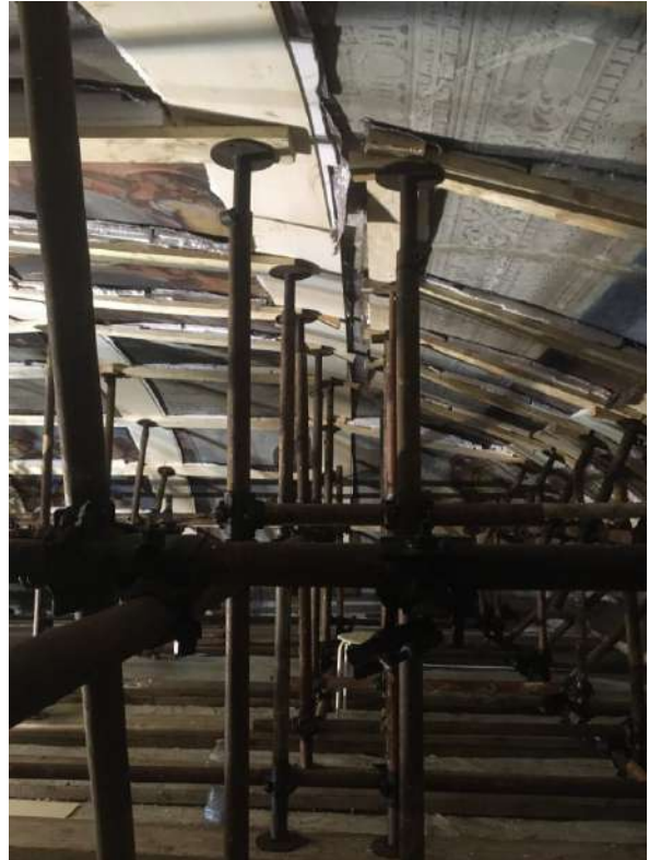
Foto: Dettaglio puntelli a sostegno della volta
