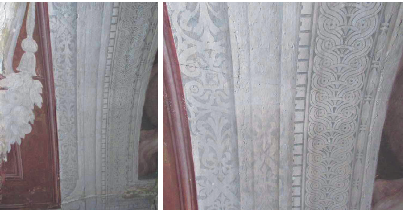
Imgg. 22 - 23– IMG_006 e IMG_007: lato nord, ridipintura della cornice verticale. Nella fotografia a destra, dopo aver tamponato con spugna umida, sono maggiormente visibili le tracce della decorazione fatta con mascherina, poi coperta dalla ridipintura. La stesura dello strato pittorico a calce in tinta unita è, forse, opera dello stesso autore che, in fase di realizzazione, potrebbe aver semplificato l'ornamento.
