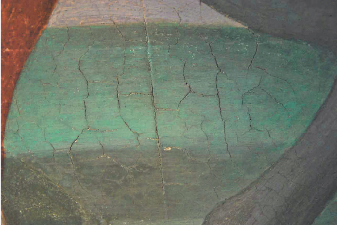
Img. 18 – DSC_0741: specchiatura ovest, crettatura dell'intonaco.
