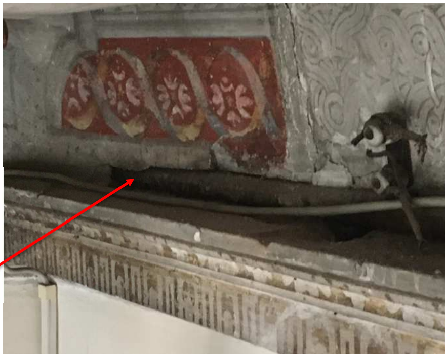
Figura 3: Immorsamento catena nel muro
