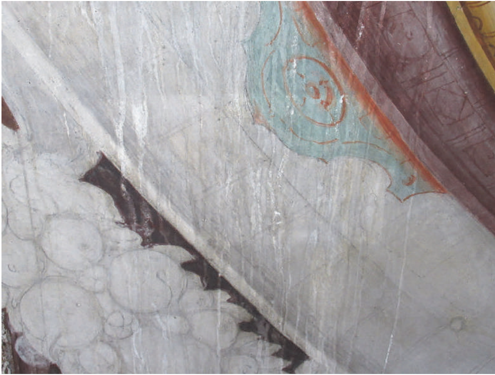
Img 9 - IMG_0887: prova pulitura con rimozione colature
