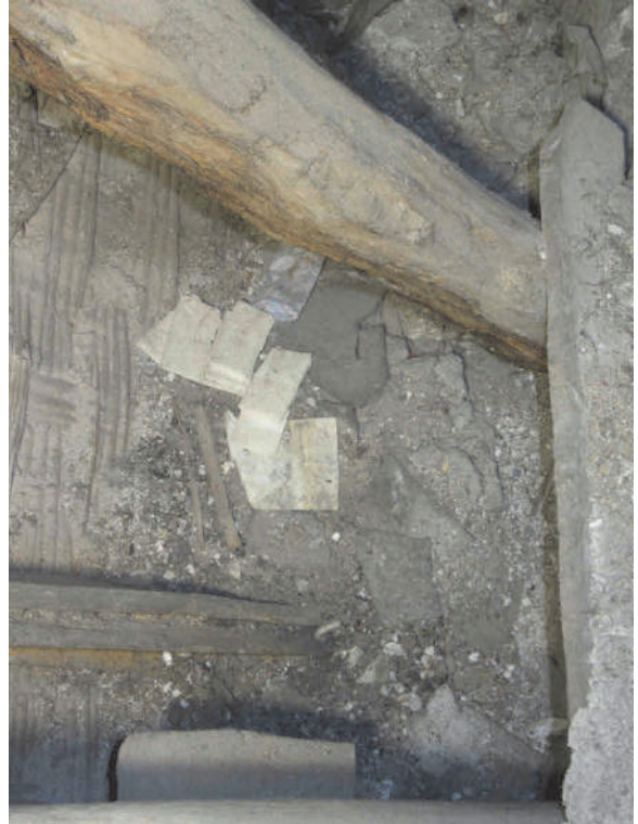
Img 2 - IMG0051: estradosso, pulitura canniccio; Img 3 - IMG0035: estradosso, detriti imposta di volta
