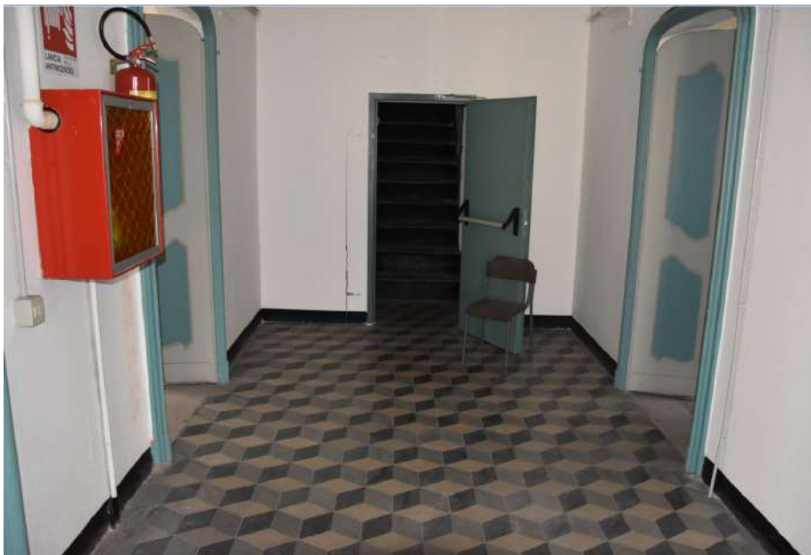
Foto: è visibile la scala di accesso alla botola
