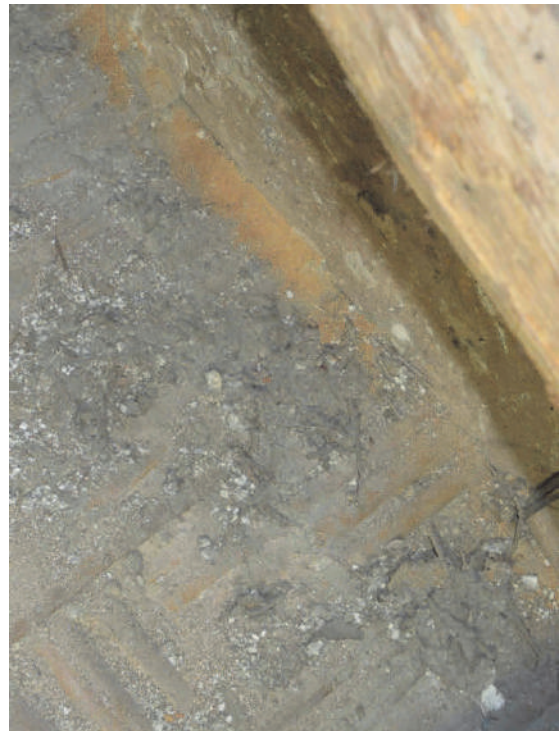
Img 5 – DSC0054: estradosso, fori di sfarfallamento insetti xilofagi; Img 6 - DSC0033: estradosso, rosura legno
