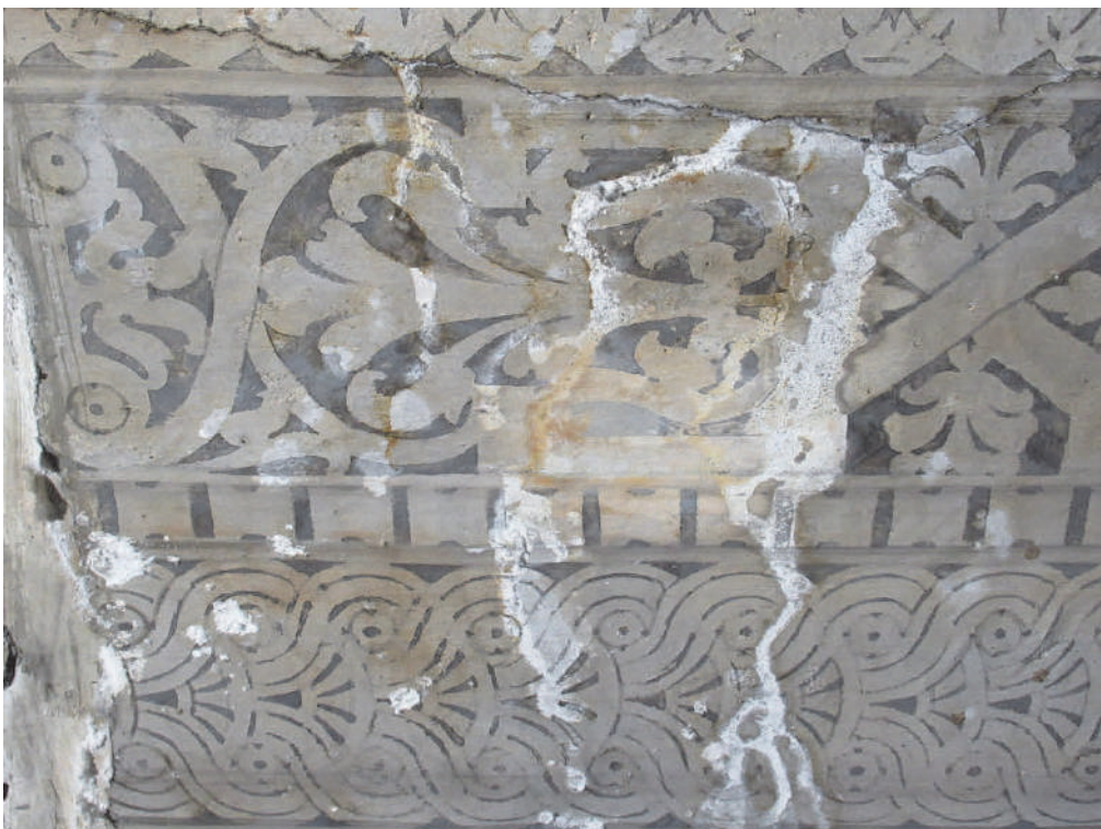
Img 8 - IMG_0896: prova pulitura con rimozione macchia di tannino
