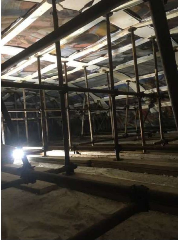
Foto: Dettaglio puntelli a sostegno della volta
