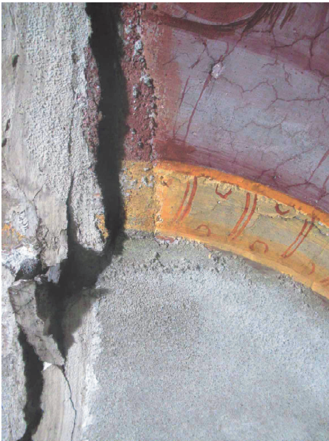
Img. 18 – IMG_0002: angolo nord-ovest, rifacimento dell'ovale con malta simile a quella utilizzata per la stuccatura n.3. Inoltre, è visibile la stuccatura n.2 sopra al rifacimento e sopra alla stuccatura n.3.
