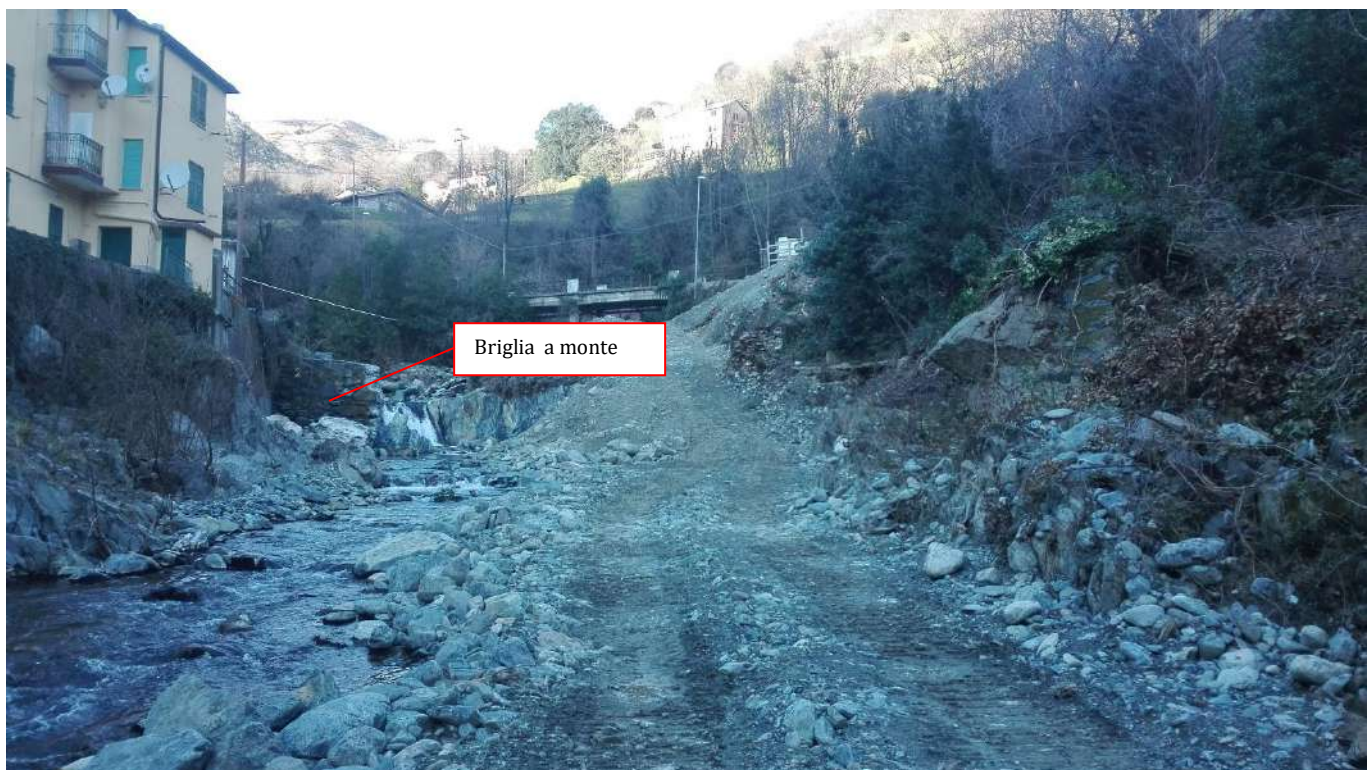
foto 4 – Rampa di discesa in alveo
