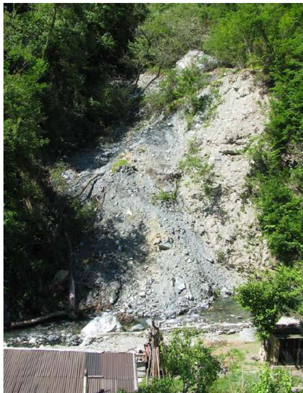
Figura 2 – Foto della frana vista da Via dei Tartari incrocio Via Fiorino (Maggio 2016)
