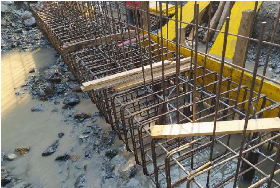
foto 11/12 – micropali e armatura cordolo testa pali Briglia di valle
