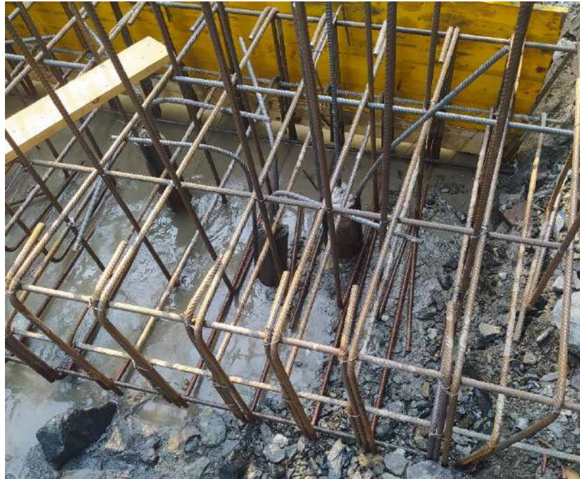
Foto 13 / 14 – realizzazione in opera del getto verticale della briglia a valle
