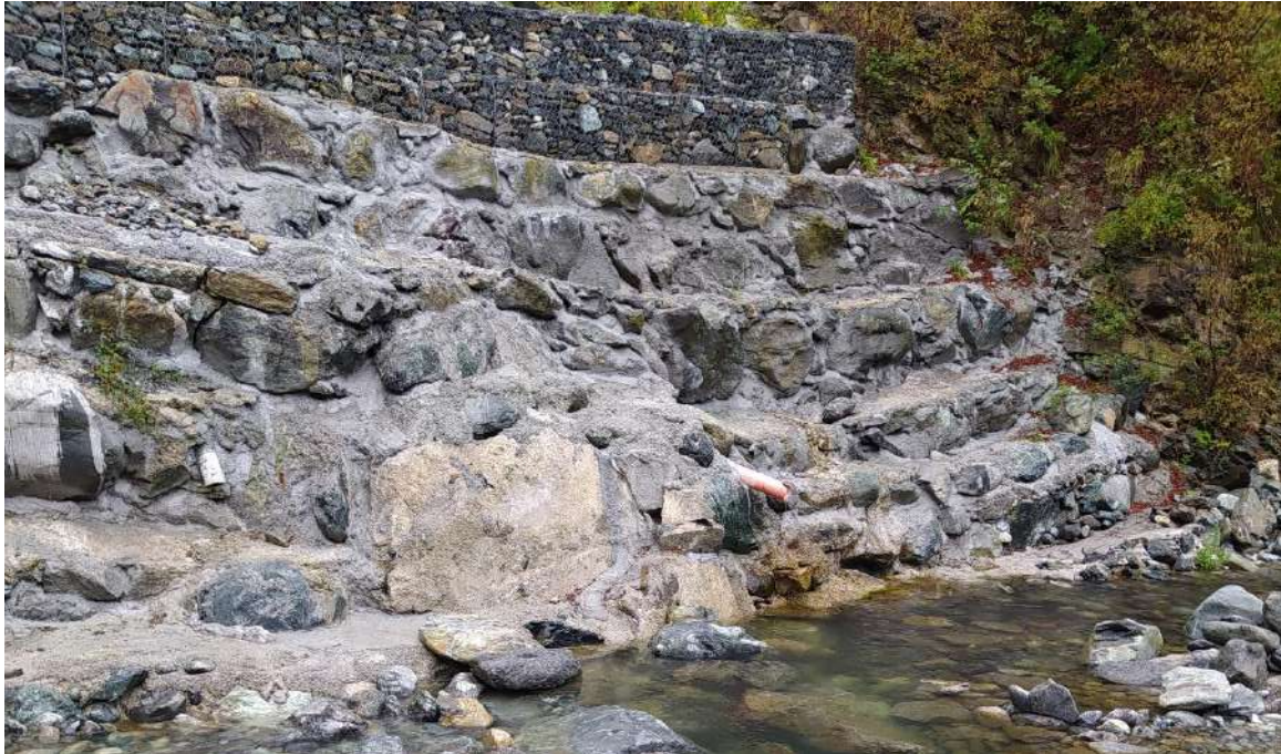
foto 8 – Scogliera allo stato realizzato
