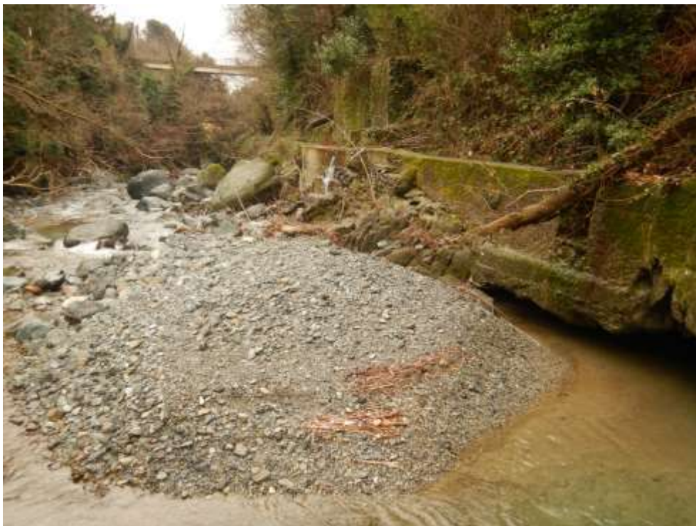
Foto 8 a,b – Anche a valle della briglia in sponda destra del T. Cerusa si trova il substrato roccioso in affioramento su cui fonda (almeno in parte) l'opera di derivazione idrica connessa alla briglia di cui trattasi e la spalla destra della briglia stessa.
