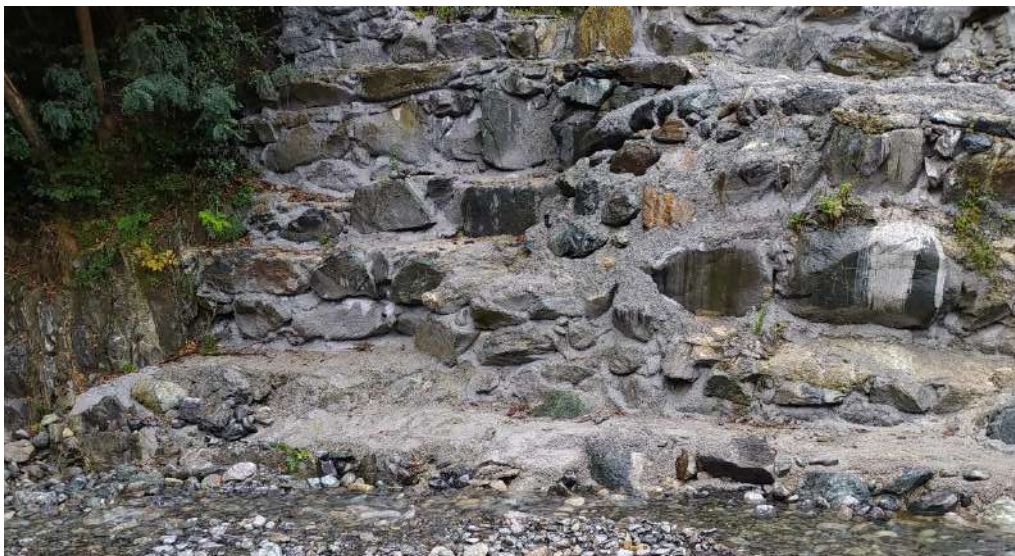
foto 9 – Scogliera allo stato realizzato
