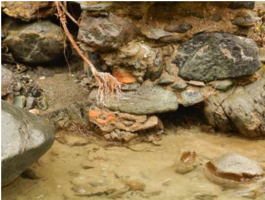
Foto 7 a,b– Sempre in sinistra idrografica, anche il moncone residuo della briglia sembra fondare sulla roccia del substrato.
