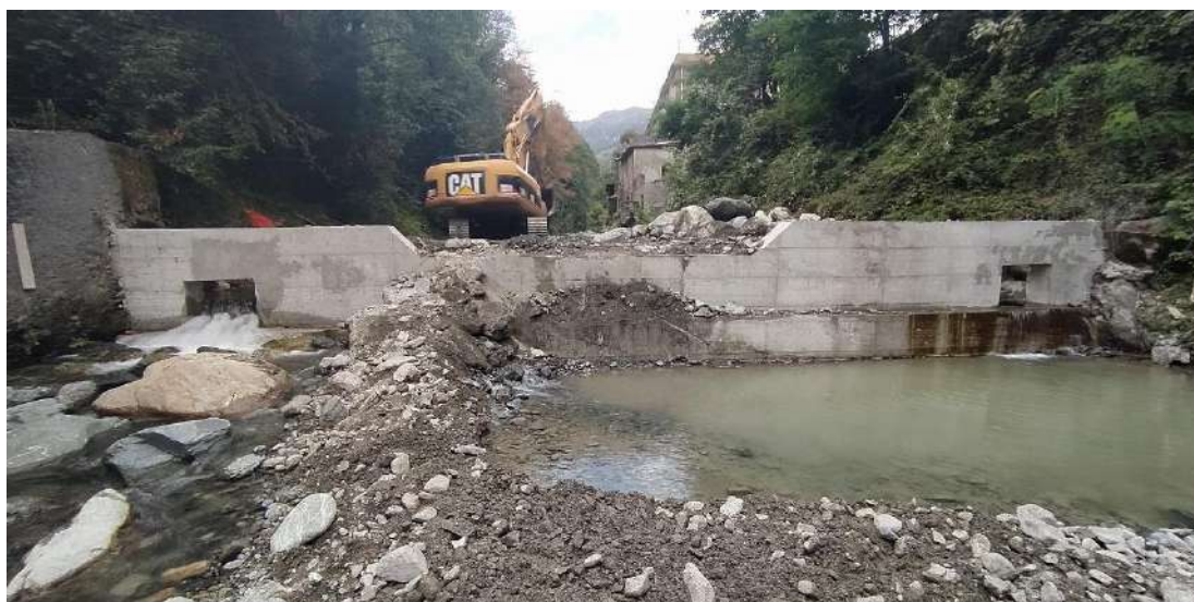
Foto 15 / 16 – realizzazione della briglia a valle e finiture
