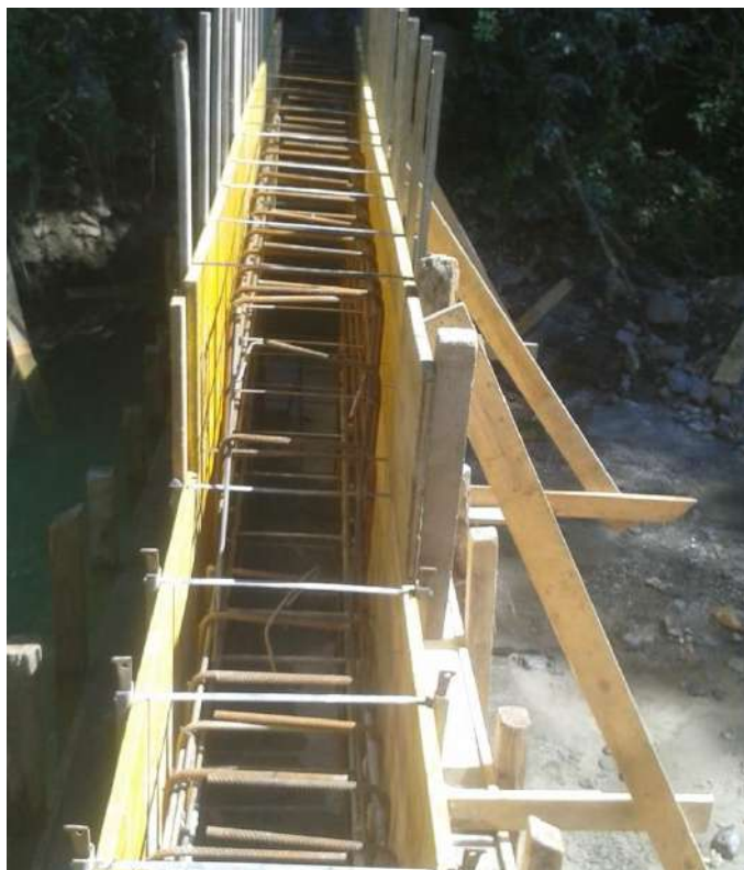
Foto 15 / 16 – realizzazione della briglia a valle e finiture
