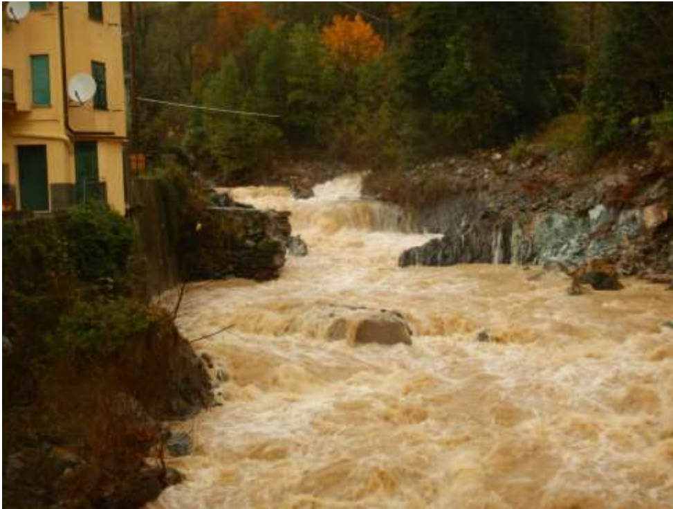
Foto 2 –La briglia di monte ormai quasi completamente demolita
