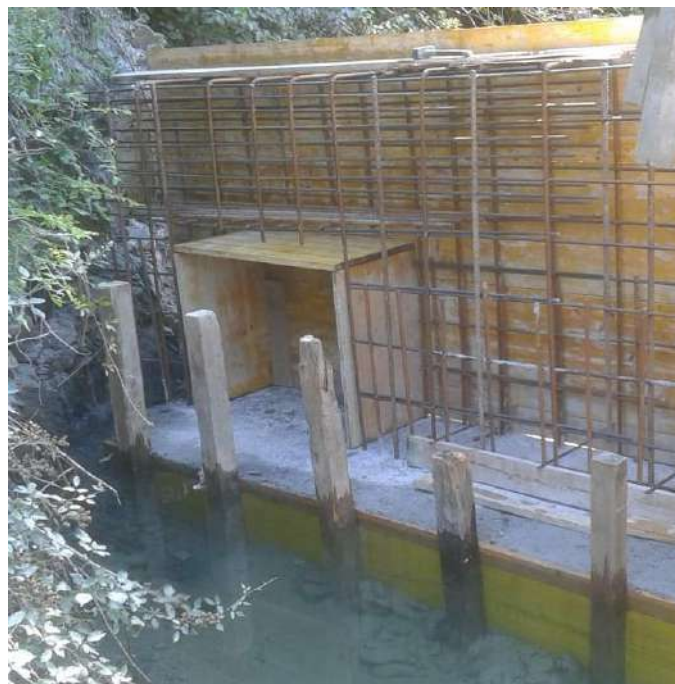
Foto 13 / 14 – realizzazione in opera del getto verticale della briglia a valle
