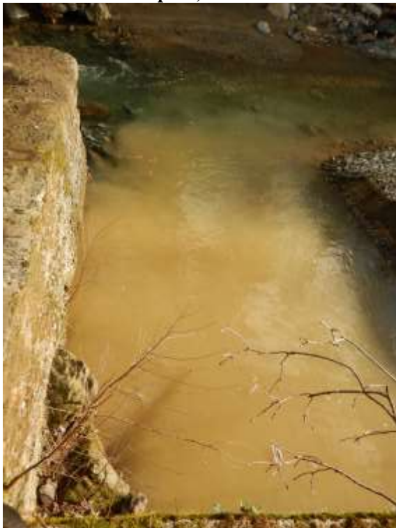
Foto 5 – Nella foto, in primo piano, si nota la roccia del substrato emergente al di sotto della spalla destra della briglia, mentre poco oltre verso il centro alveo il saggio approfonditosi per oltre 1,5 m non ha incontrato il bedrock.
