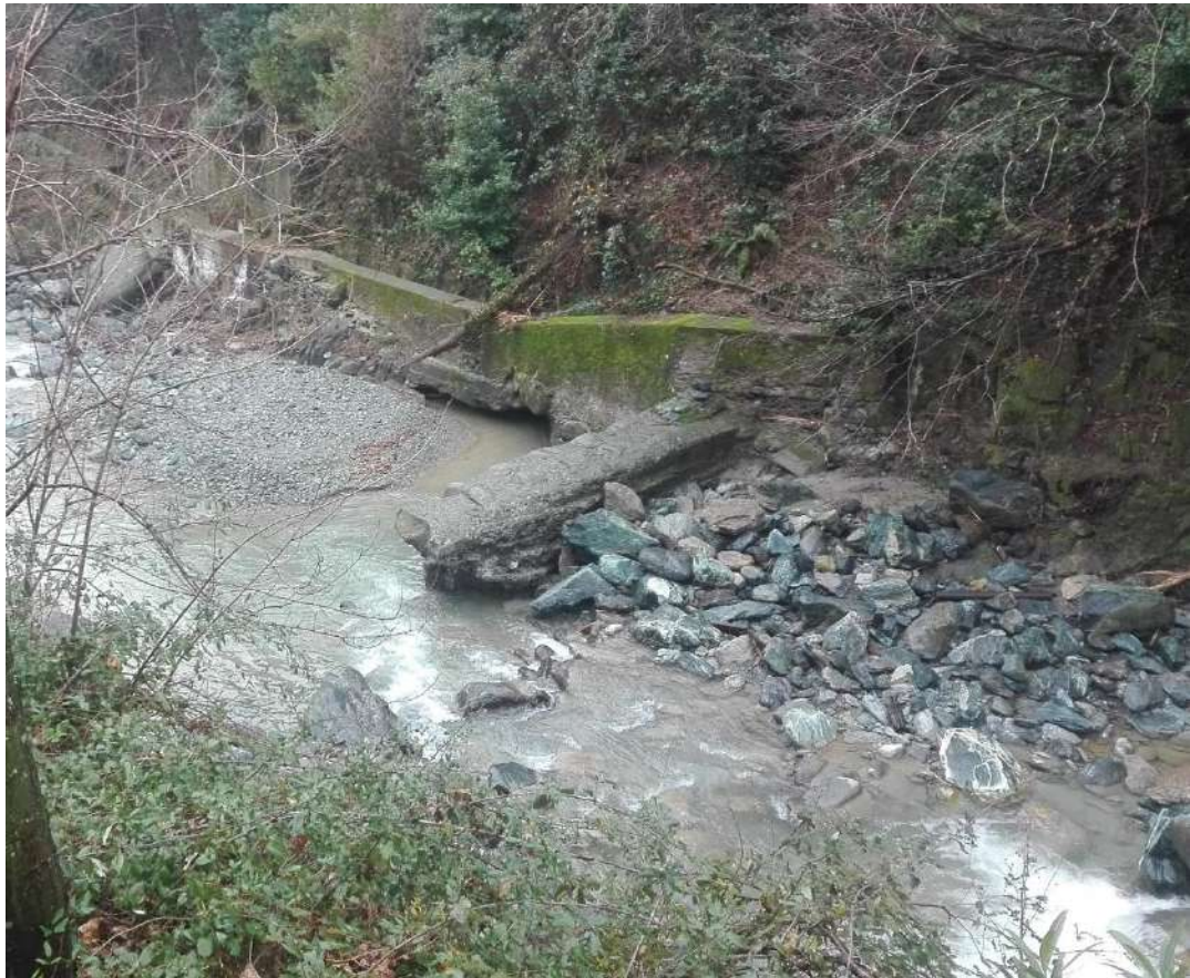
foto 10 – Briglia di valle allo stato di fatto
