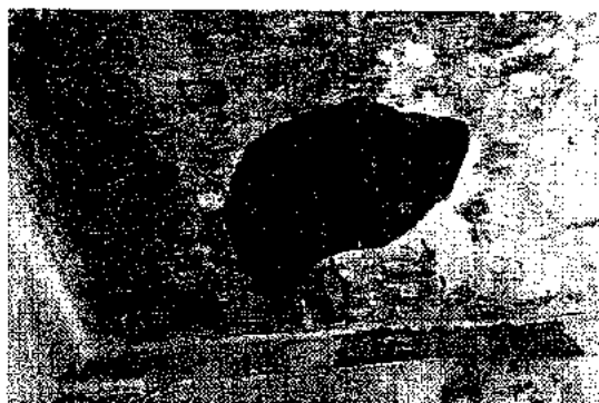
Foto 21: Solaio sfondellato
