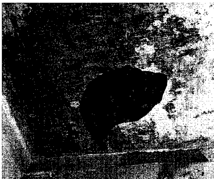
Foto 8: Solaio sfondellato
