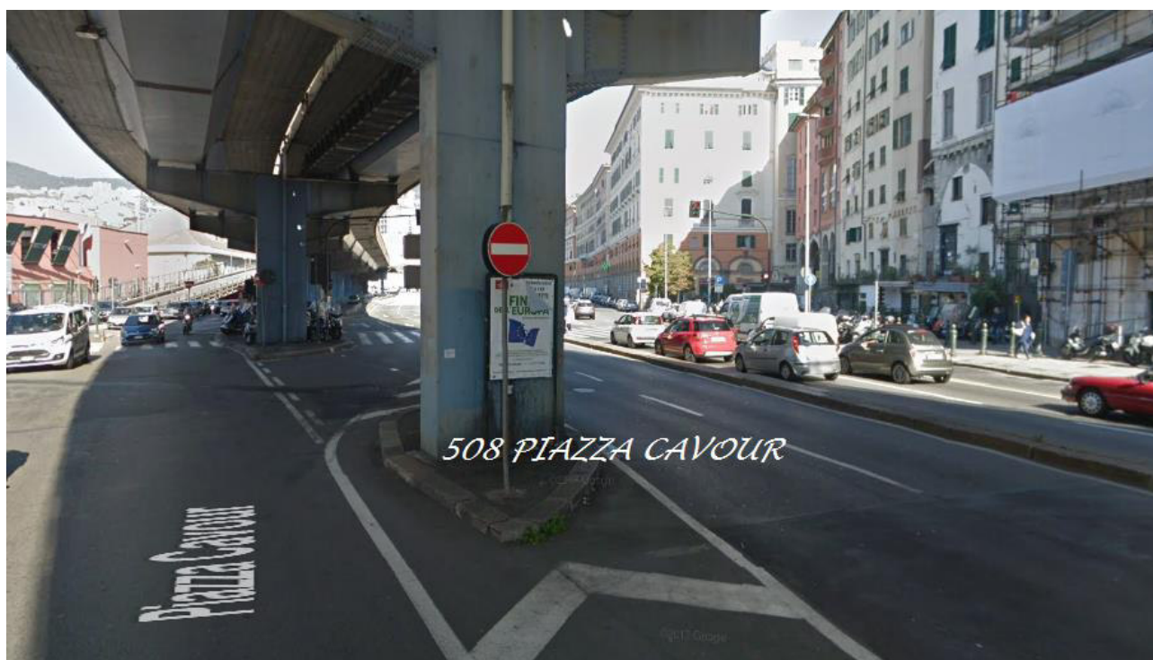
Lotto 7: Impianto n. 508 sito in Piazza Cavour
