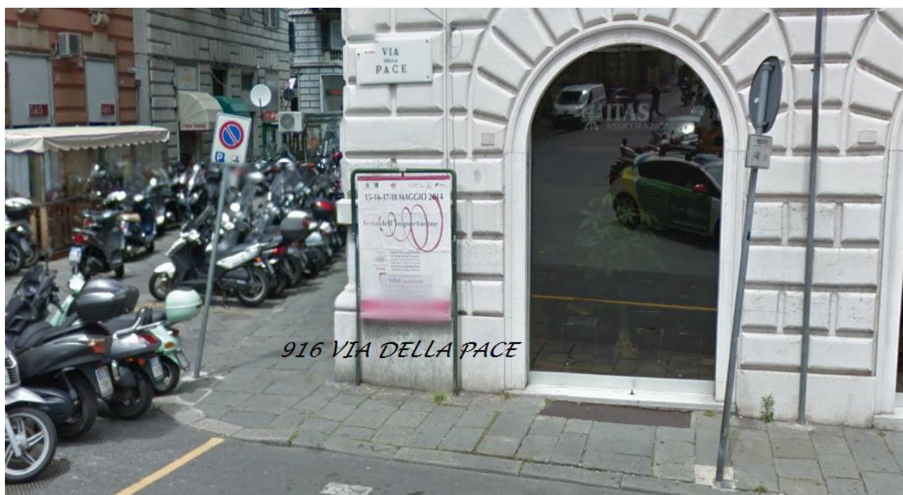
Lotto 27: Impianto n. 916 sito in Via della Pace
