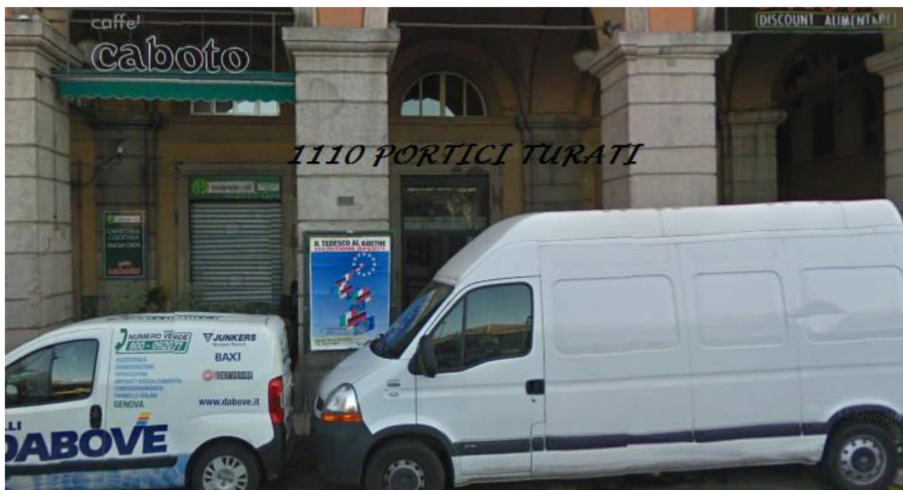
Lotto 36: Impianto n. 1110 sito in Via Filippo Turati
