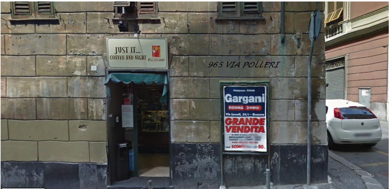
Lotto 31: Impianto n. 965 sito in Via Polleri
