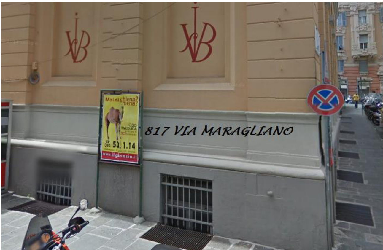
Lotto 24: Impianto n. 817 sito in Via Anton Maragliano
