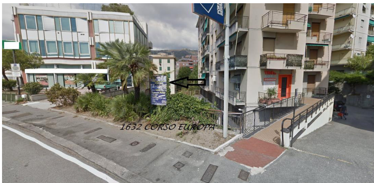
Lotto 45: Impianto n. 1632 sito in Corso Europa
