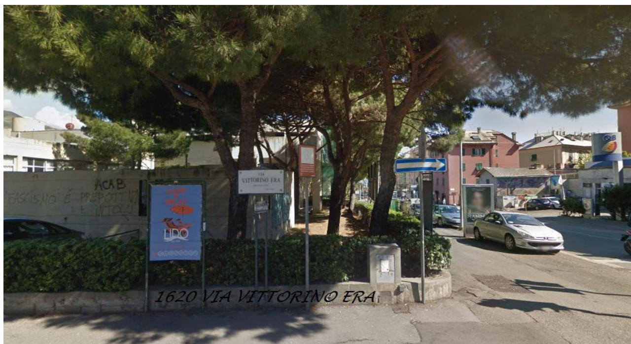
Lotto 44: Impianto n. 1620 sito in Via Era
