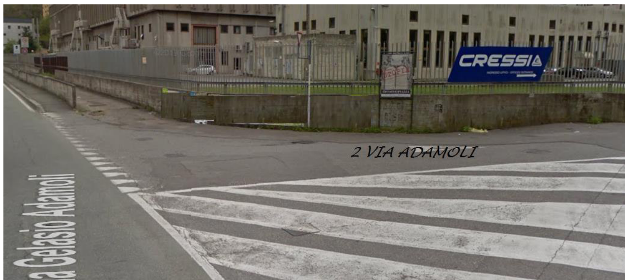
Lotto 1: Impianto n. 2 sito in Via Adamoli
