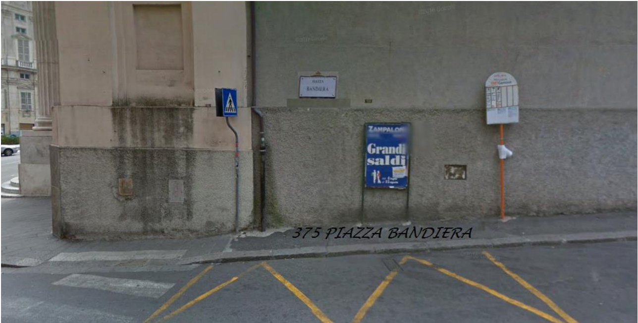
Lotto 5: Impianto n. 375 sito in Piazza Bandiera
