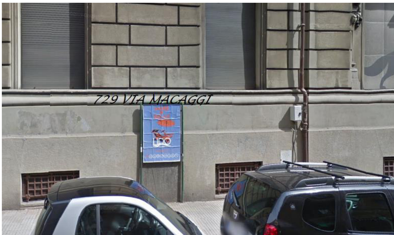
Lotto 19: Impianto n. 729 sito in Via Macaggi
