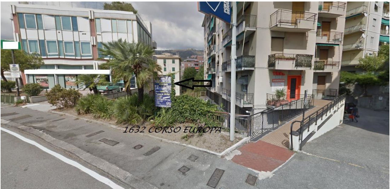
Lotto 45: Impianto n. 1632 sito in Corso Europa
