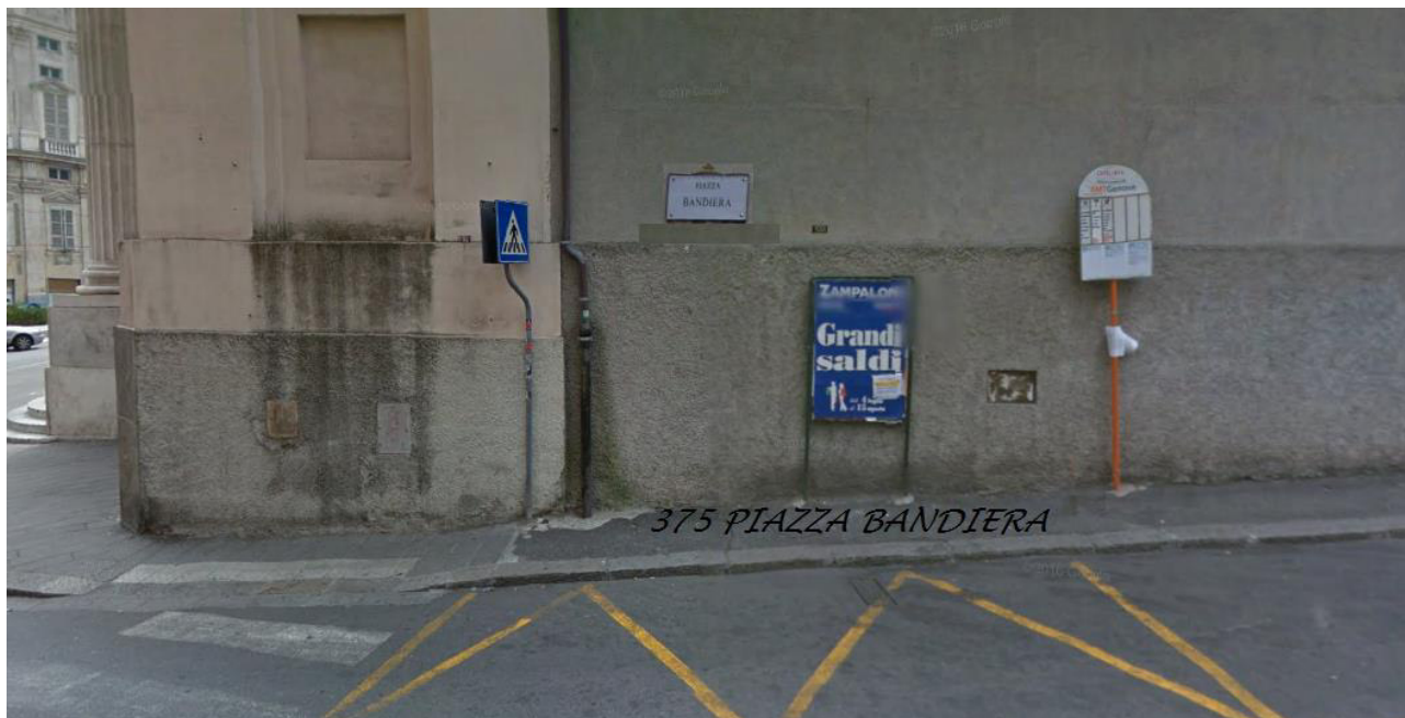
Lotto 5: Impianto n. 375 sito in Piazza Bandiera
