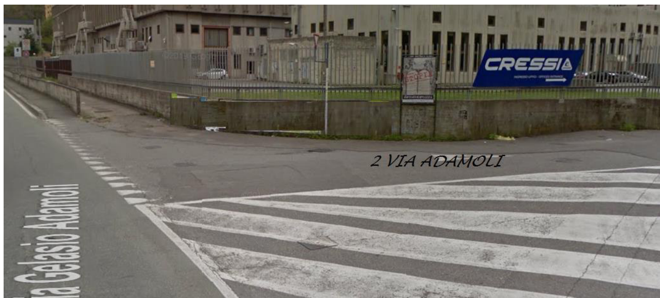
Lotto 1: Impianto n. 2 sito in Via Adamoli
