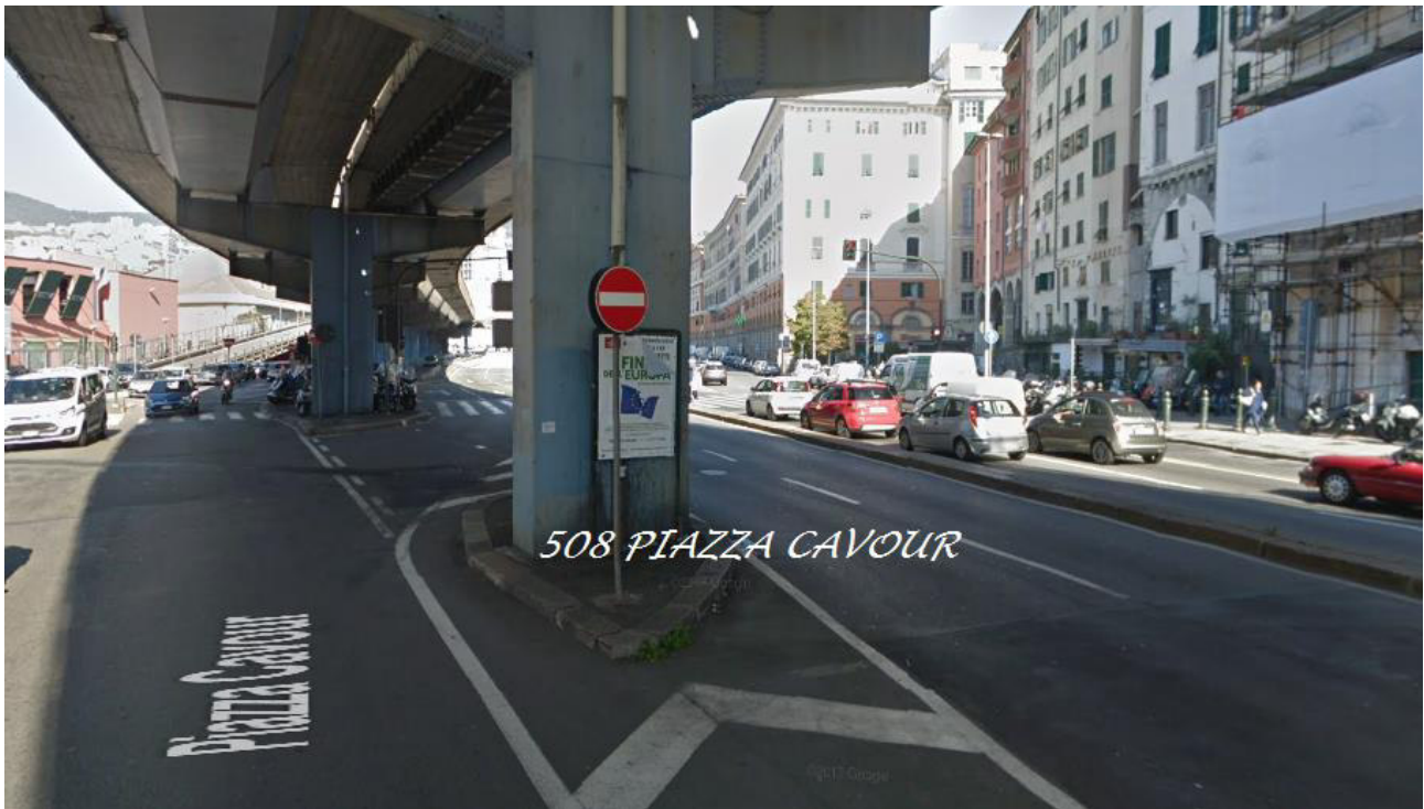
Lotto 7: Impianto n. 508 sito in Piazza Cavour
