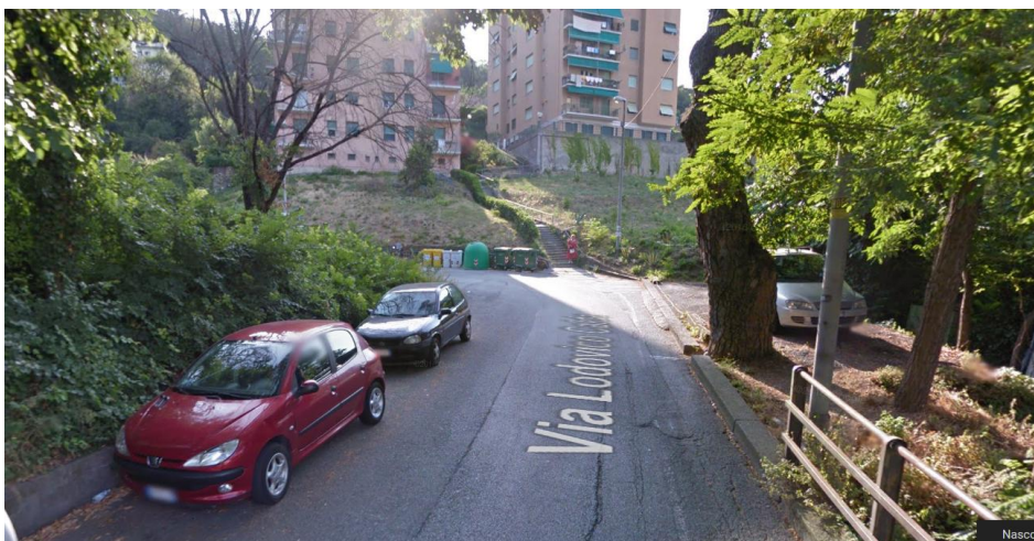
LA SEZIONE STRADALE DI VIA CALDA - TRATTO DEL TORNANTE A SX -
