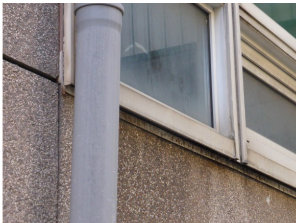
Figura 4.5 – Rilievo termografico dei serramenti
