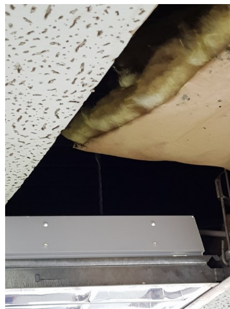
Figura 4.2 - Particolare della coibentazione della copertura
