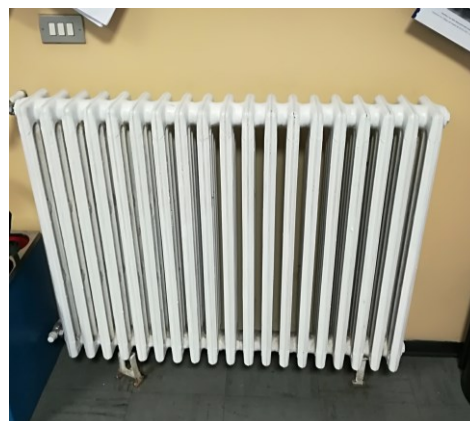
Figura 4.7 - Particolare dei radiatori installati sulle pareti delle aule
