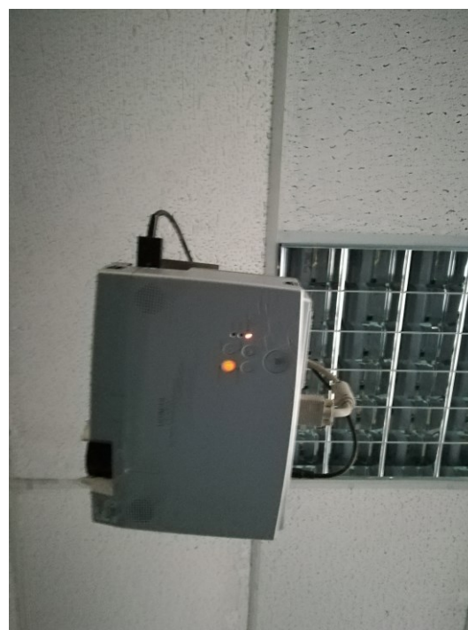
Figura 4.15 - Particolare dei corpi illuminanti ubicati nelle aule
