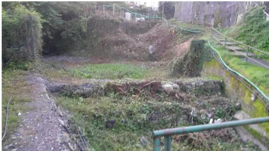
FOTO 1 - Tratto a monte - Confluenza con rio secondario, sono presenti una briglia ed una vasca di decantazione che necessita di interventi di svuotamento con cadenza semestrale per mantenere la sua funzionalità.
