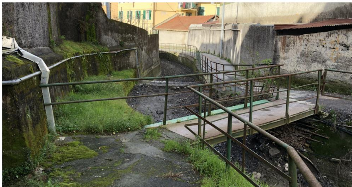
FOTO 2 - Tratto a monte – Passerella pedonale e tratto adiacente a via Rio Fulle, zona indicata in fascia A di inondabilità.
