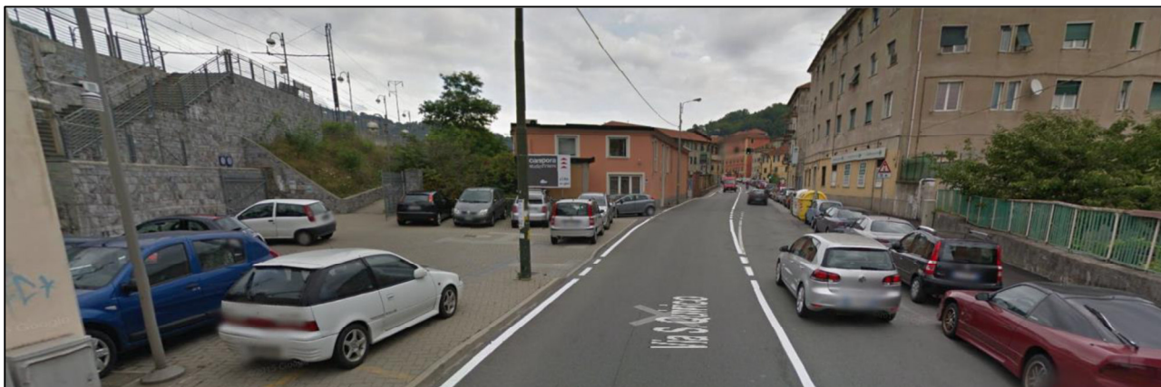
Zona di intervento con eventuali lavorazioni in notturna
