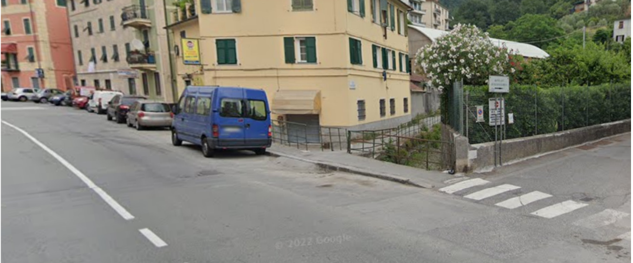
Zona di intervento presso l'attuale ingresso della tombinatura
