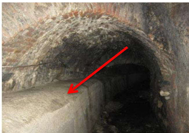
FIG.3 – Vista interna della Roggia dei Mulini con il bauletto fognario sulla destra
