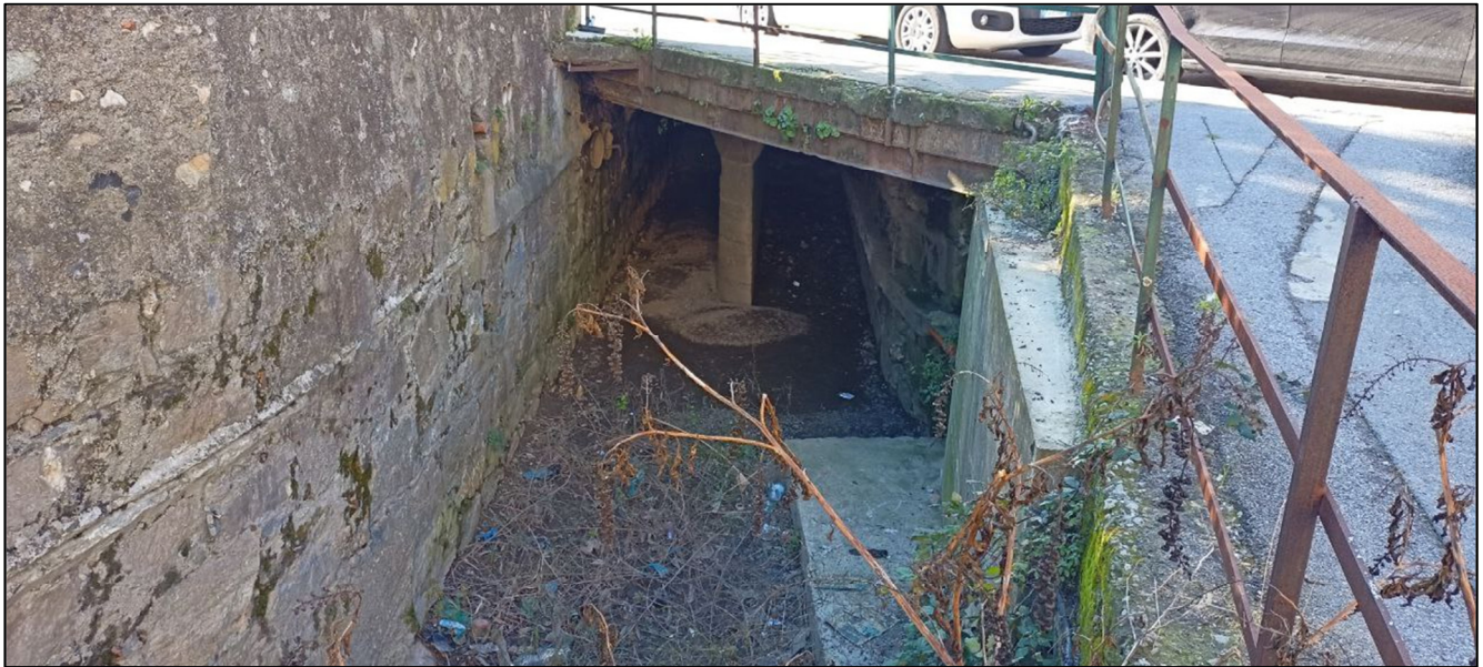
FOTO 4 - Tratto a monte – Imbocco della tombinatura
