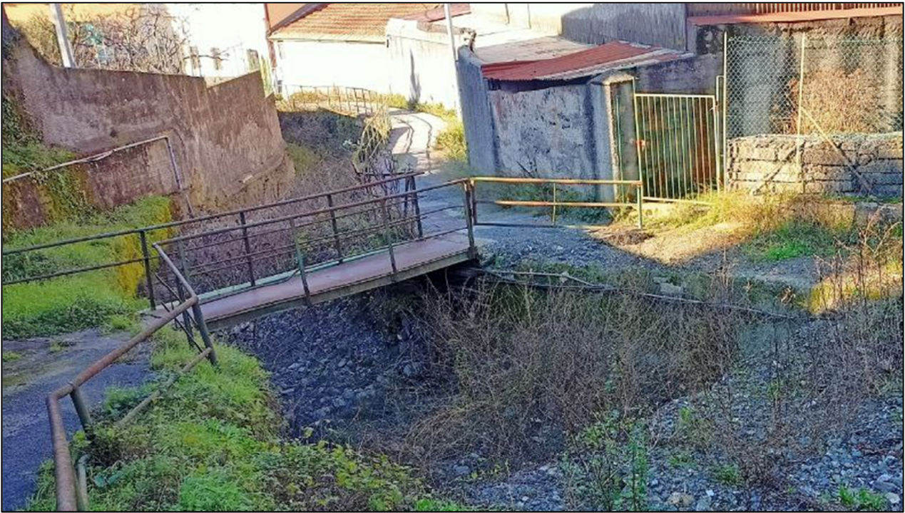
FOTO 2 - Tratto a monte – Passerella pedonale e tratto adiacente a via Rio Fulle, zona indicata in fascia A di inondabilità.
