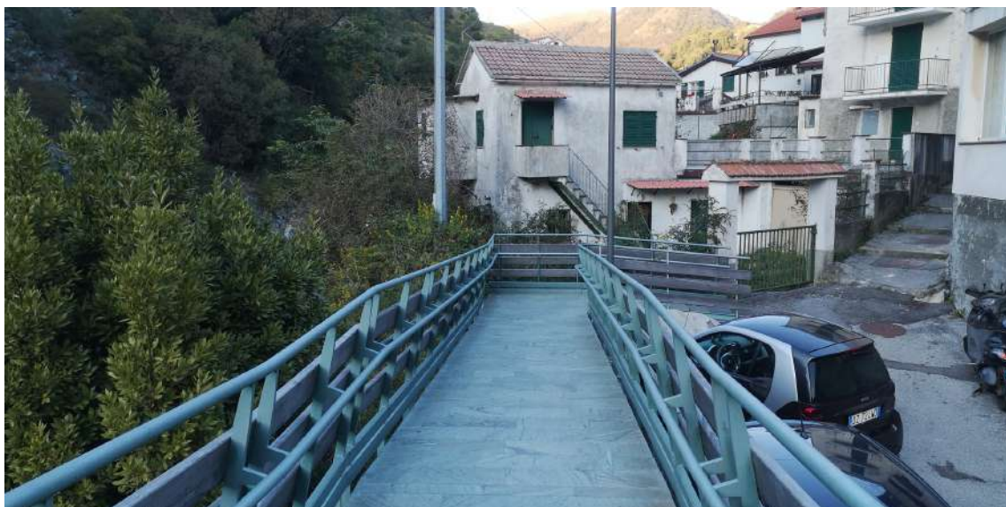
Foto n. 4: rampa d'accesso alla passerella pedonale, a cui si deve raccordare il nuovo muro d'argine in sponda sinistra; il relativo allineamento è determinato dalla tangenza al muro della rampa, al palo ENEL e all'edificio visibile sullo sfondo.
