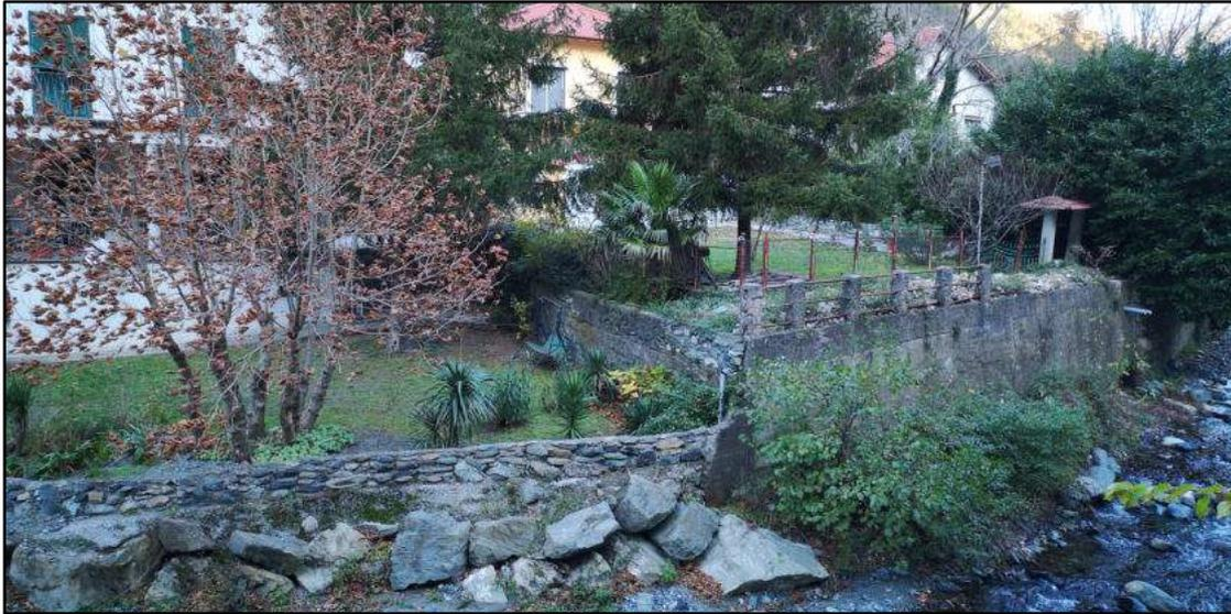
**FOTO N. 5** Vista della sponda destra effettuata dalla sponda sinistra: si nota il gradone presente in corrispondenza dell'ultimo tratto arginale, in prossimità dell'ultima casa in sponda destra.
