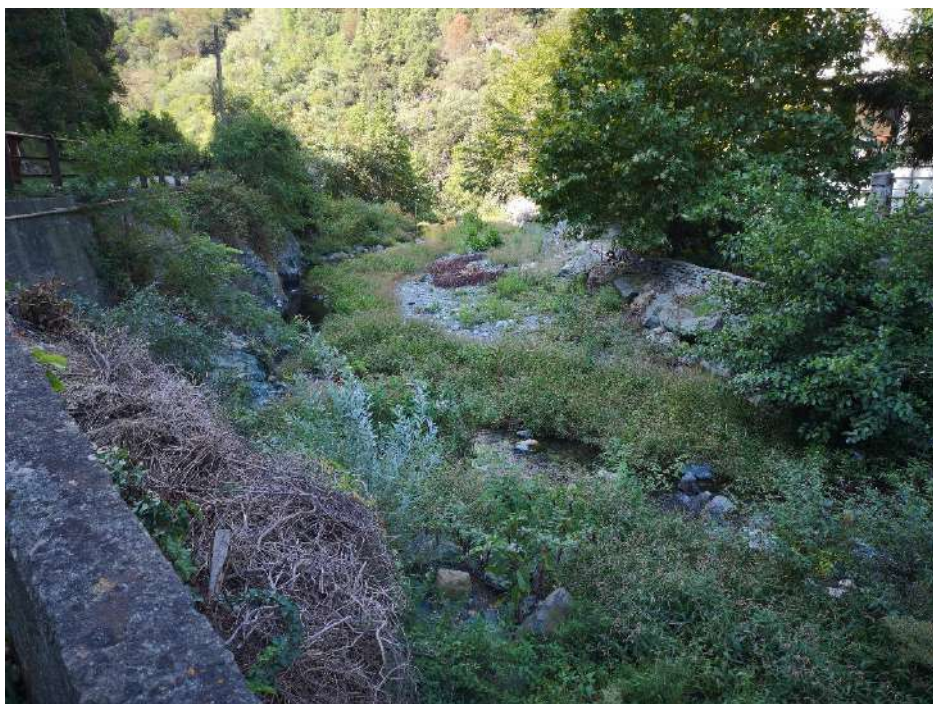
Vista del tratto terminale dell'intervento in sponda destra, ove si intravede la briglia esistente, sulla quale termina il nuovo muro d'argine
