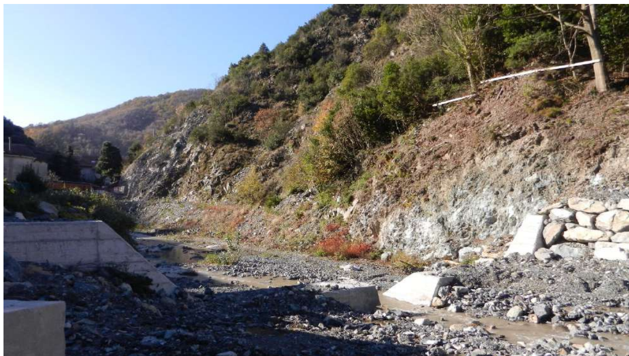
briglia a monte dell'abitato di San Carlo di Cese con la difesa spondale in massi ciclopici
