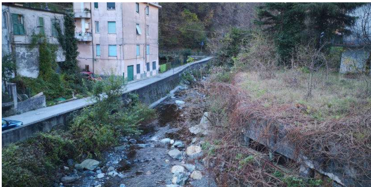
Vista del secondo tratto, visto dalla spalla destra della passerella pedonale, ove il nuovo muro in destra taglierà l'edificio collabente visibile in primo piano.
