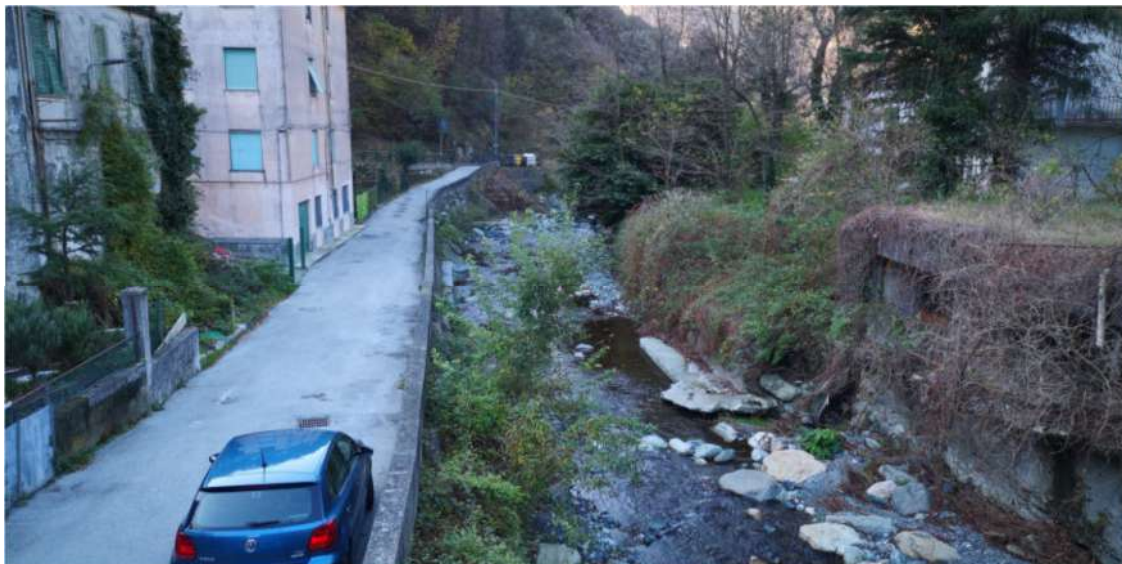
Vista del secondo tratto, visto da monte, dalla spalla sinistra della passerella pedonale, ove il nuovo muro in sinistra si svilupperà in corrispondenza del muretto esistente.
