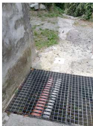
foto 2: termine 2° tratto, vista verso valle
