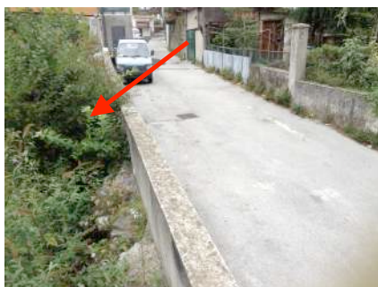
foto 4: 4° tratto, interrato, con vista del chiusino
