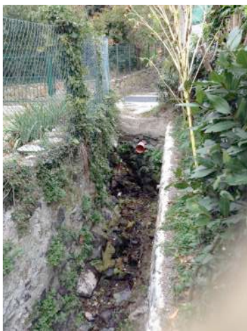
foto 3: 3° tratto, vista verso monte
