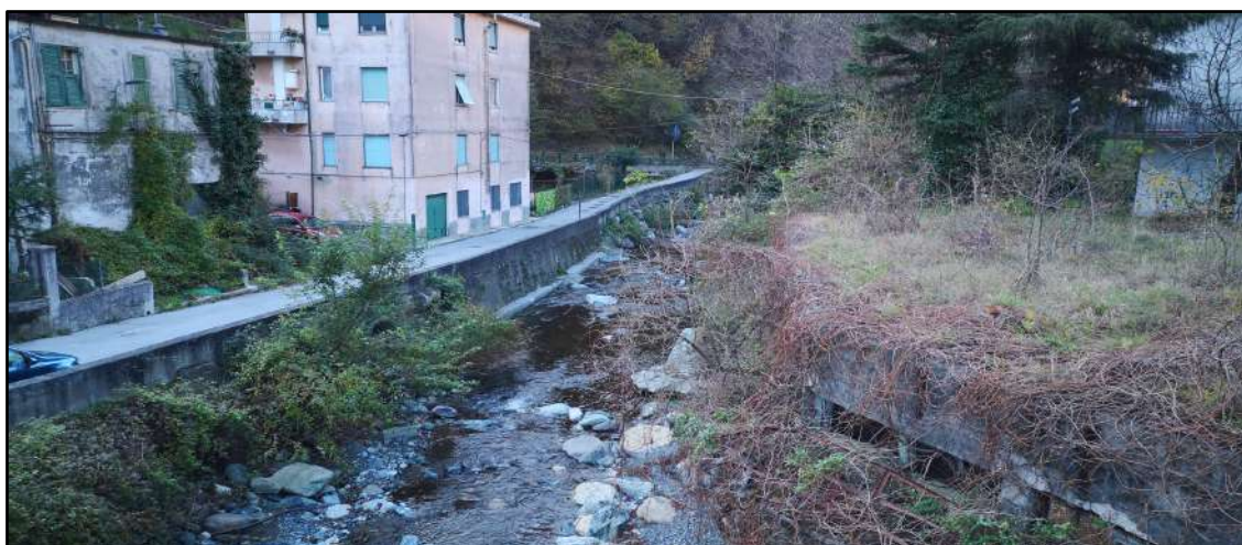
Foto del secondo tratto, visto dalla spalla destra della passerella pedonale, ove il nuovo muro in destra taglierà l’edificio collabente visibile in primo piano.
