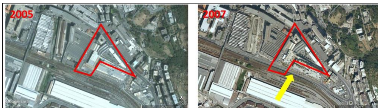
Figura 21. Immagini satellitari dell'area ex Esaote (2005 e 2007): nel riquadro rosso l'area di progetto, la freccia gialla indica il nuovo asse stradale di via Albareto (da www.pcn.minambiente.it e Google Earth (c) )
