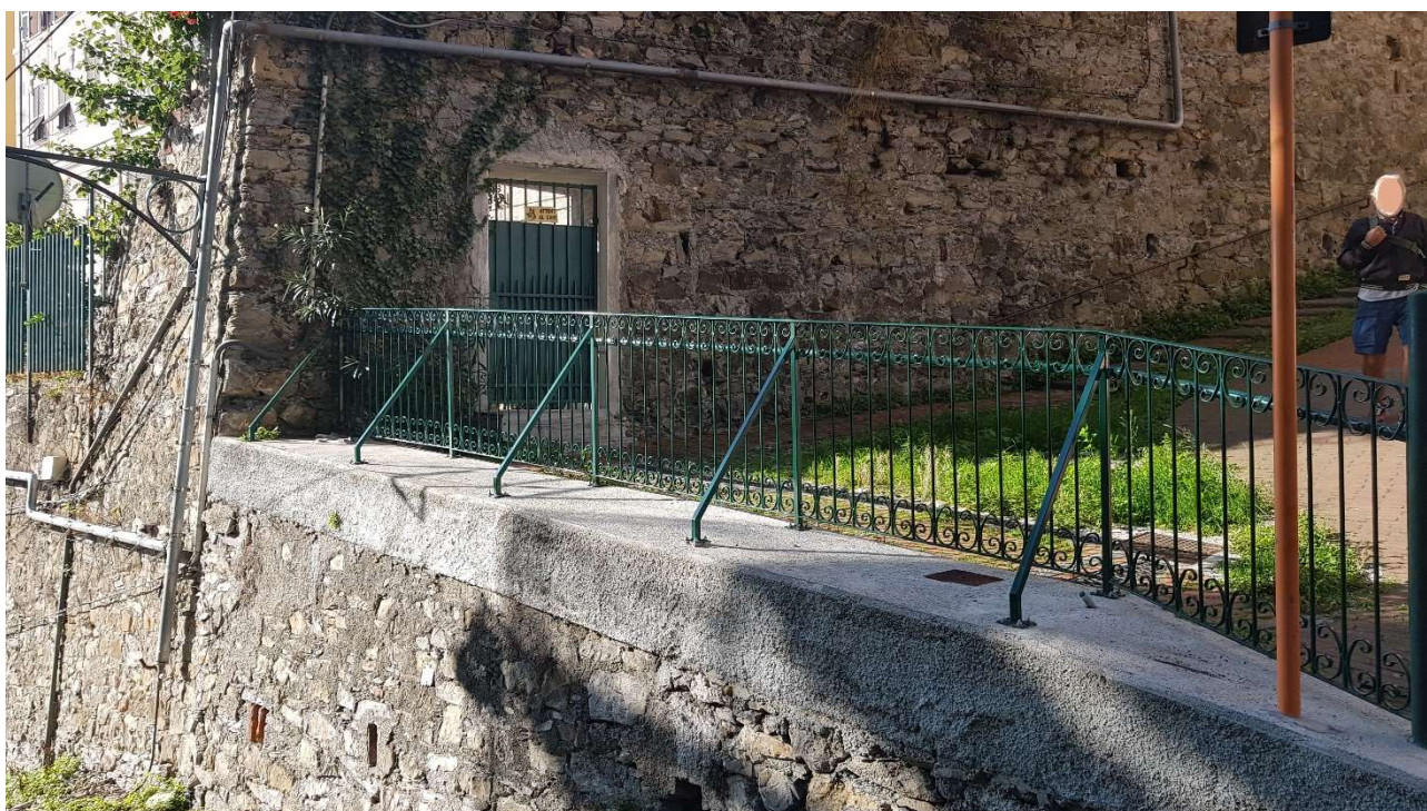
Figura n. 28 -Attraversamento di Salita S. Rocco - Esempio di ringhiera dopo la manutenzione
