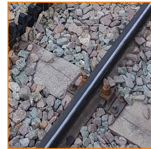
FOTOGRAFIA ESEMPLIFICATIVA DI UNA NUOVA TRAVERSINA GIA' IN OPERA
