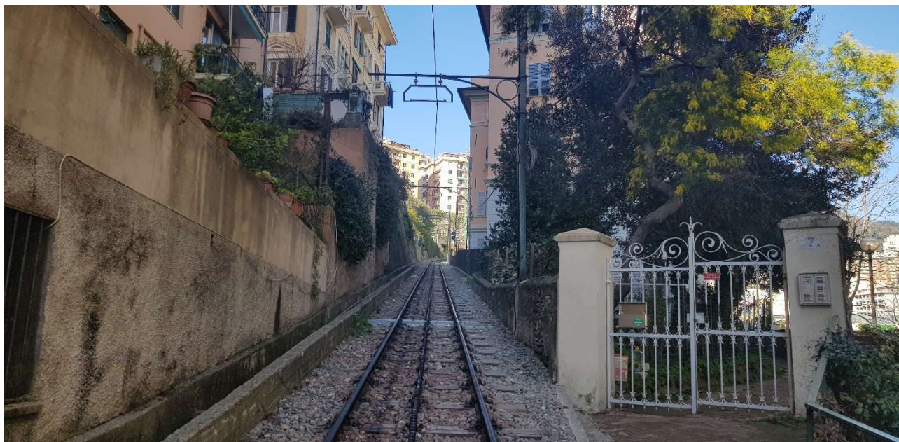
Figura n. 36 - Foto n° 1 - Civico 7A in Salita S. Rocco dove ha inizio l'intervento di realizzazione del nuovo camminamento di servizio
