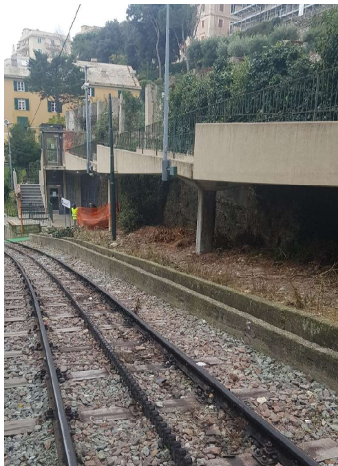
Figura n. 3 - Tratto tipico della ferrovia con canaletta laterale di raccolta acque meteoriche (vista della passerella pedonale che collega via Bari alla fermata Centurione esistente anche con un ascensore)
