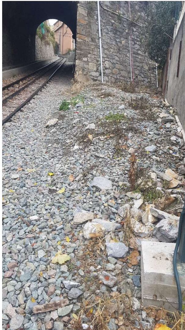
Figura n. 24 - Slargo a valle della galleria di via Bari che verrà interessato dalla nuova pavimentazione
