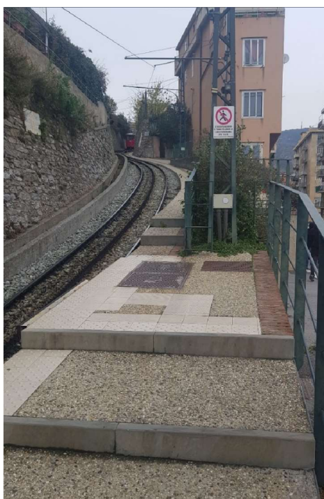
Figura n. 7 - Fermata Bari - Particolare dei gradini e dei percorsi per non vedenti (soluzione che verrà adottata anche in fermata Centurione)
