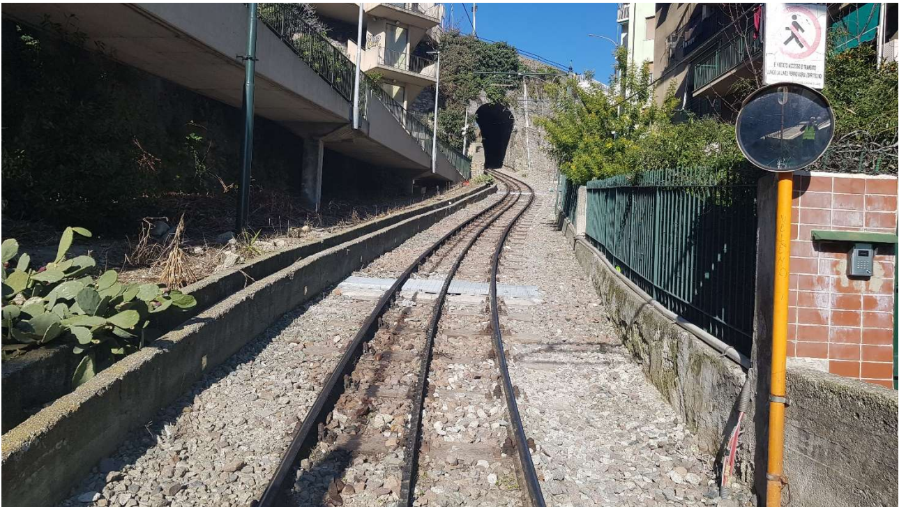
Figura n. 46 - Foto n° 11 - Recinzione da demolire e sostituire con il camminamento in progetto
