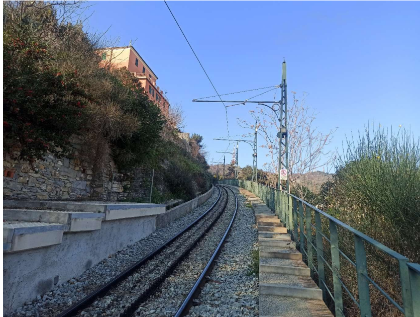
Figura n. 22 - Aspetto finale con i tralicci esterni al camminamento, in un tratto già interessato dall'ammodernamento
