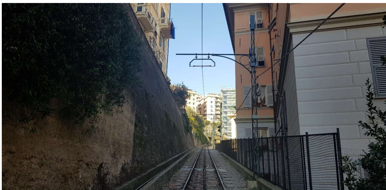
Figura n. 37 - Foto n° 2 - Recinzione da demolire e sostituire con il camminamento in progetto
