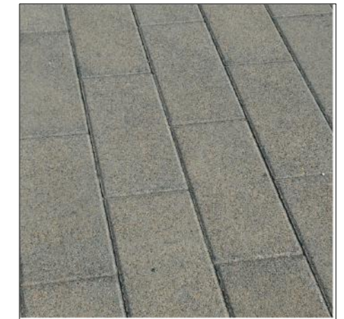
PAVIMENTAZIONE FASCIA DI RISPETTO PRA'
