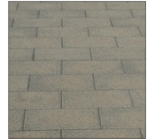
PAVIMENTAZIONE FASCIA DI RISPETTO PRA'
