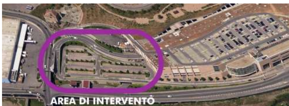
Figura 1: Vista aerea zona di intervento
