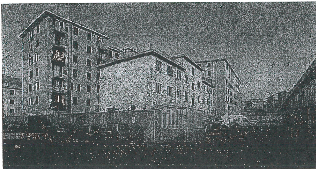
Edificio bianco oggetto d'intervento di demolizione e ricostruzione
