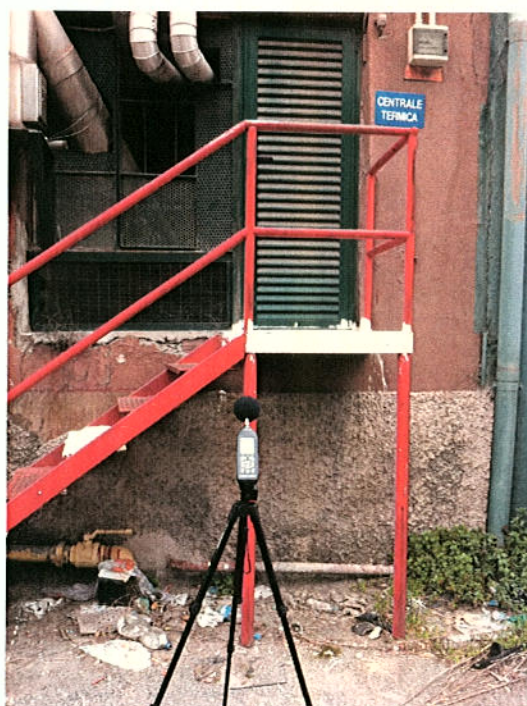
Figura 4 – Postazione di misura 4 (in esterno di fronte centrale termica)
