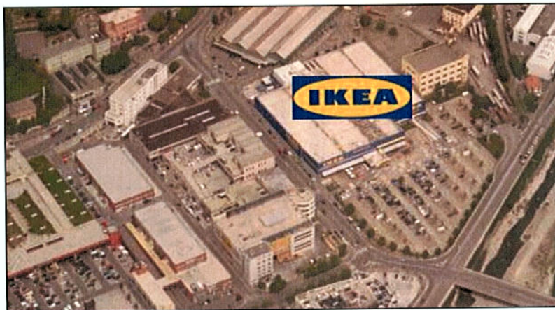
Figura 16: inquadramento territoriale di dettaglio – struttura commerciale oggetto di ampliamento (IKEA)
