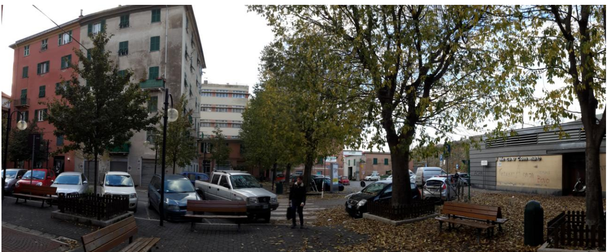
Foto 6 Vista panoramica dalla piazza, da sx a dx: edificio residenziale a sud, azienda di distribuzione bevande (Partesa), parcheggio, edificio soggetto a intervento
