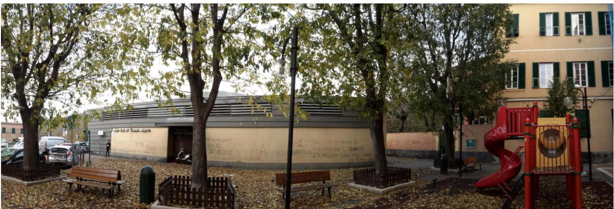
Foto 5 Vista panoramica dalla piazza, da sx a dx: parcheggio, nuovo edificio soggetto a intervento, parco giochi, centro sociale
